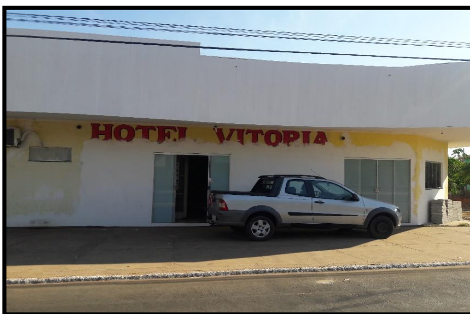
Figura 5 - Fachada do Hotel na parte central da cidade (em reforma)
