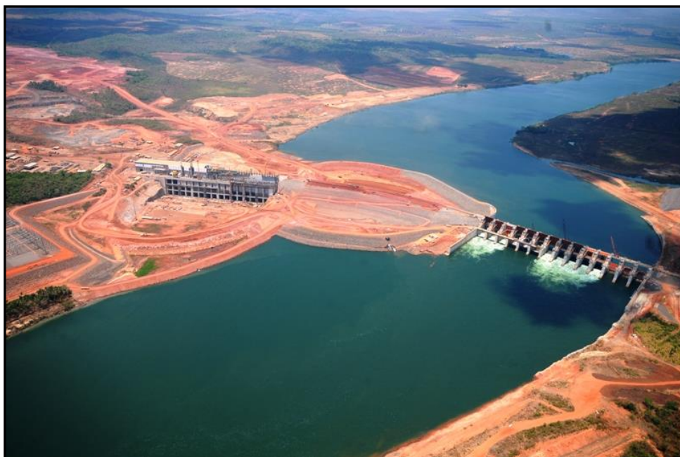
Fotografia 6 – Área de construção da barragem da Usina Hidrelétrica de Estreito (MA)
