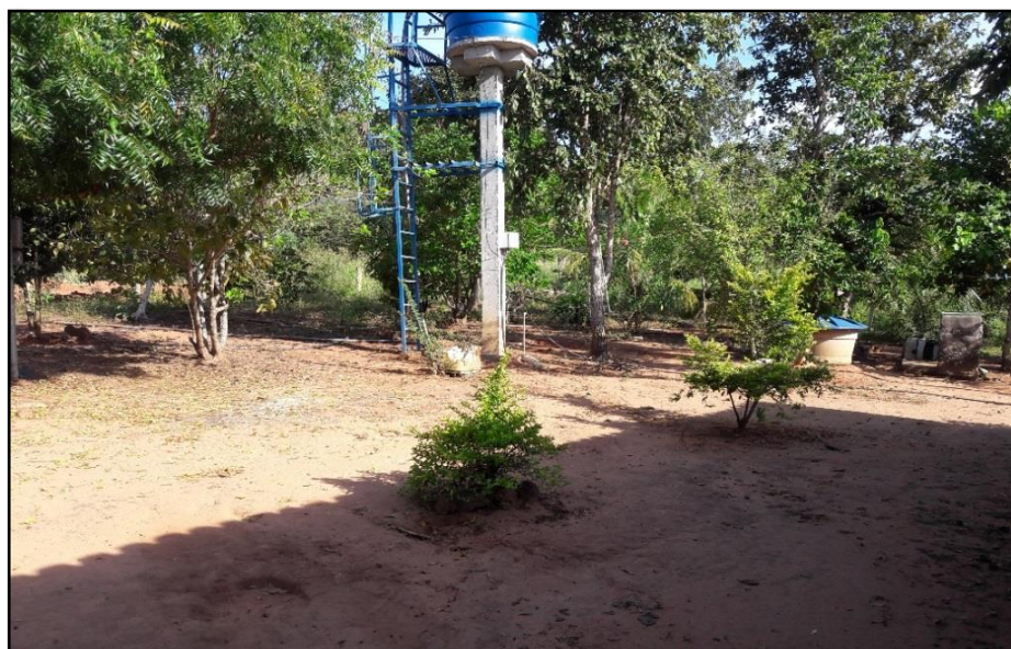
Fotografia 29 – Base do reservatório de água em reassentamento rural Babaçulândia (TO)
