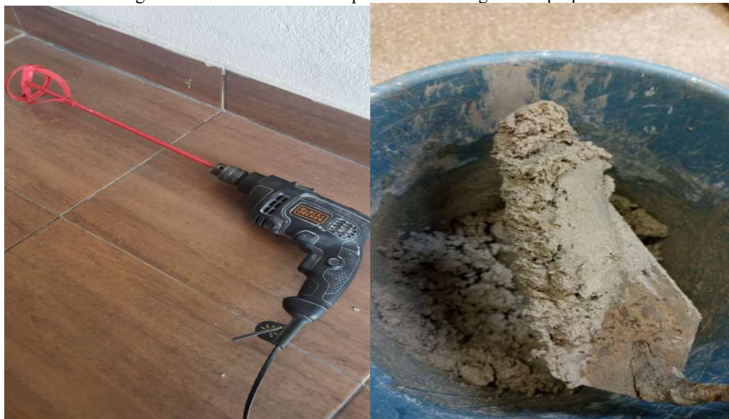
Figura 8: Furadeira com haste para mistura e argamassa preparada
