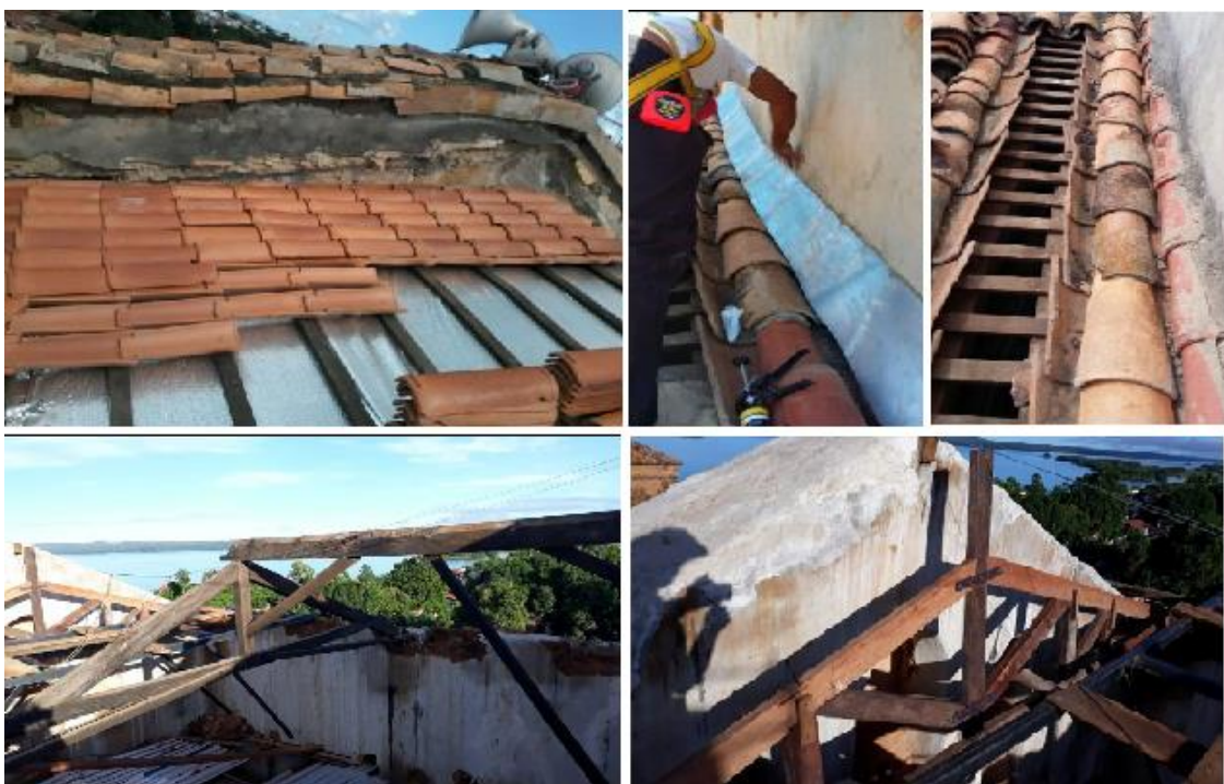
Figura 14 – Substituição de peças e colocação de peças novas.
