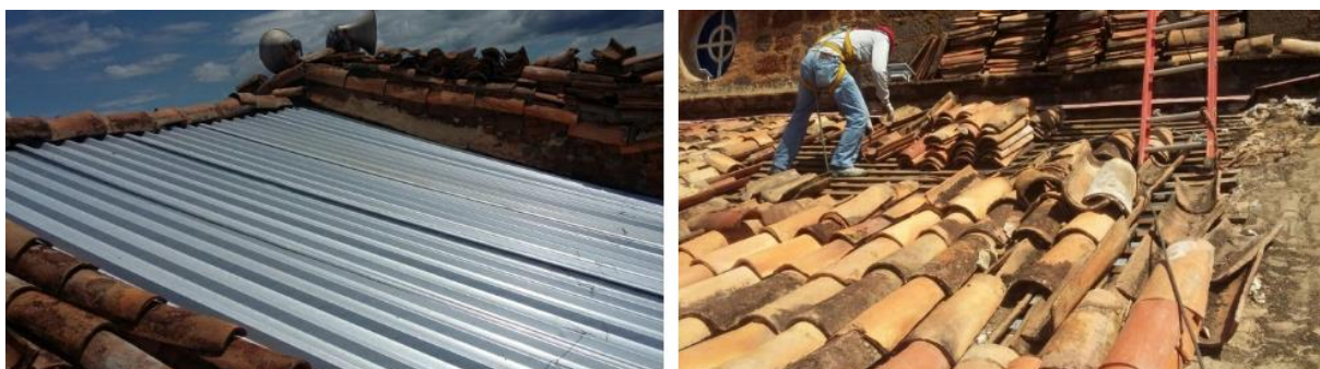
Figura 13 - Cobertura Provisória da Catedral.
