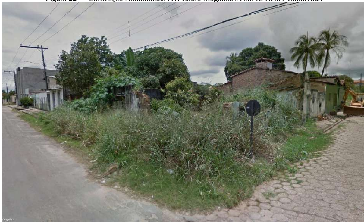
Figura 22 — Edificação Abandonada Av. Couto Magalhães com R. Henry Condreaux
