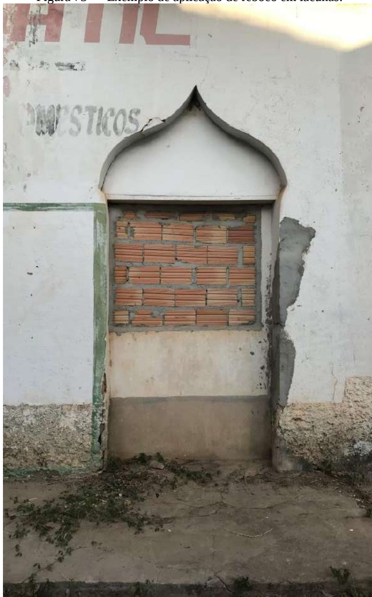
Figura 73 — Exemplo de aplicação de reboco em lacunas.
