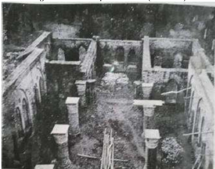
Figura 17 — Construção da Catedral (1917-1932)
