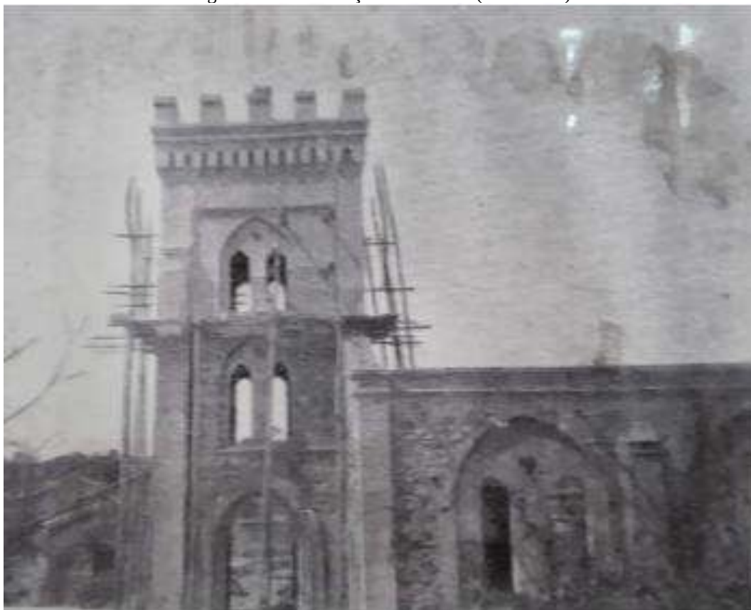
Figura 18 — Construção da Catedral (1917-1932)
