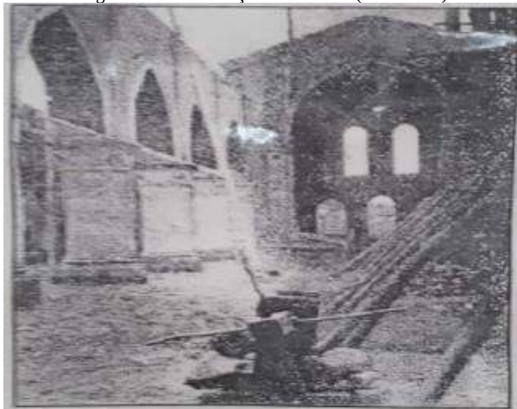
Figura 16 — Construção da Catedral (1917-1932)
