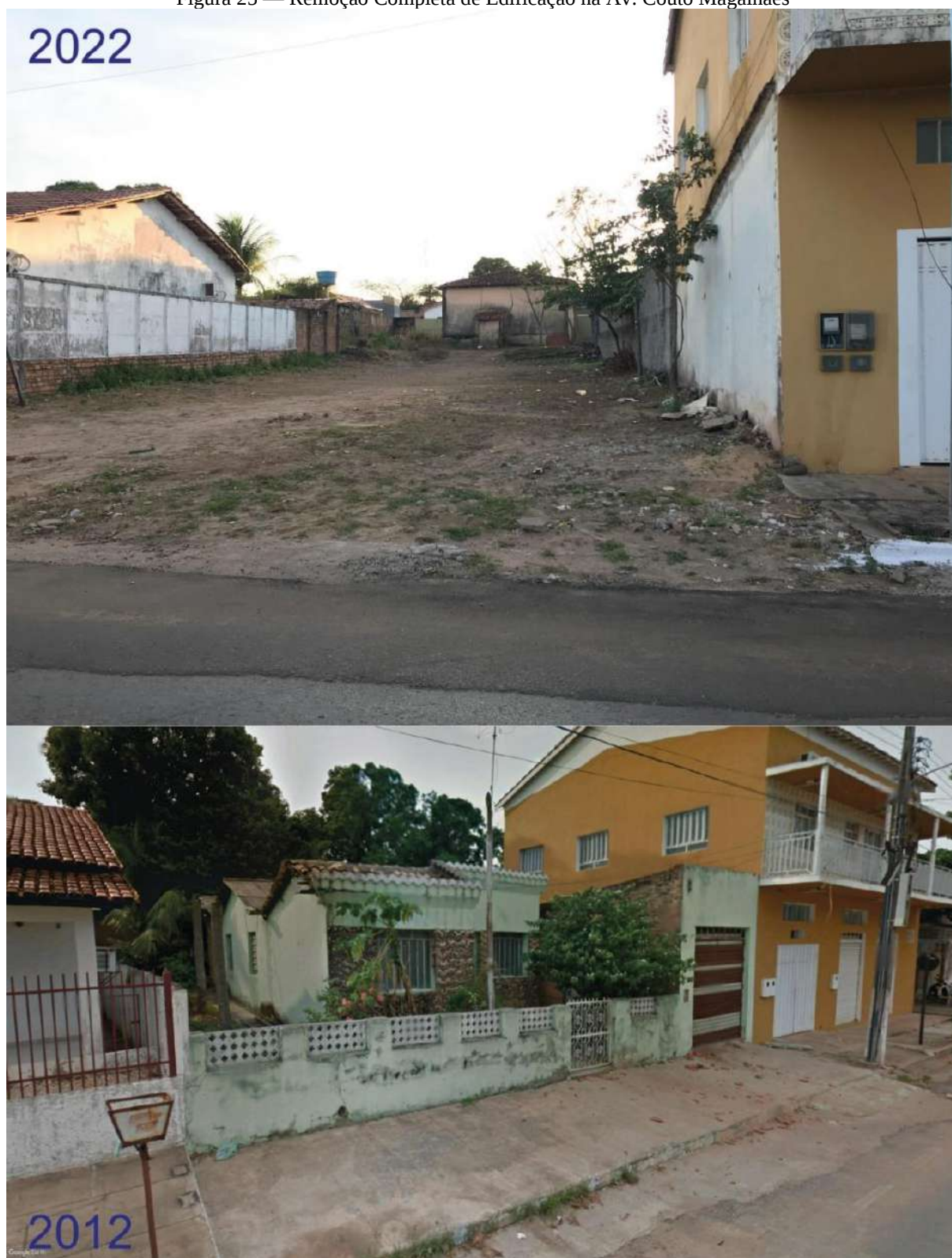
Figura 25 — Remoção Completa de Edificação na Av. Couto Magalhães
