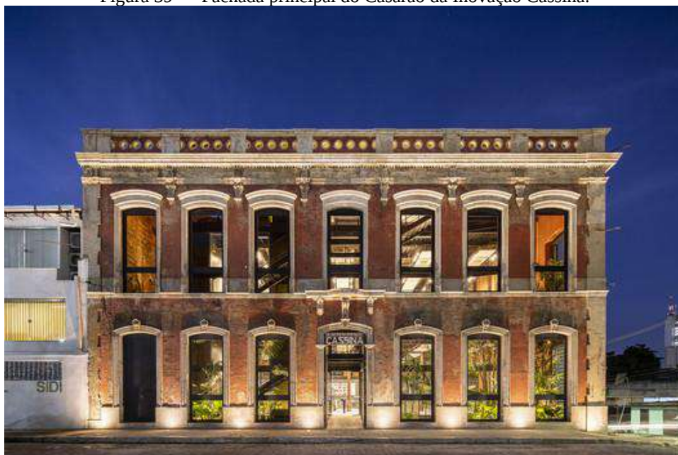
Figura 39 — Fachada principal do Casarão da Inovação Cassina.
