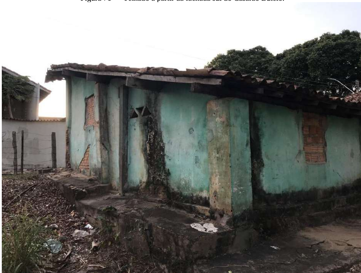
Figura 71 — Telhado a partir da fachada sul do Casarão Butelo.
