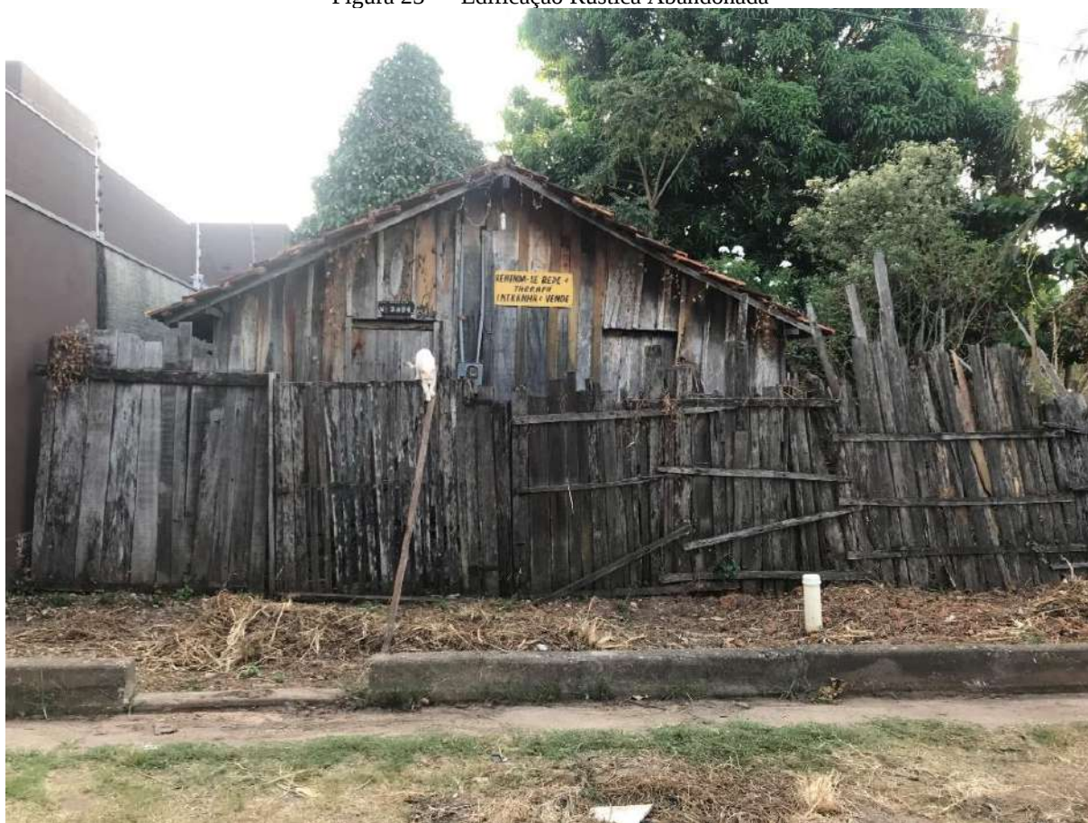
Figura 23 — Edificação Rustica Abandonada
