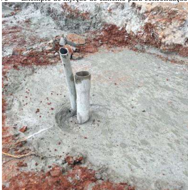
Figura 79 — Exemplo de injeção de cimento para consolidação do solo.
