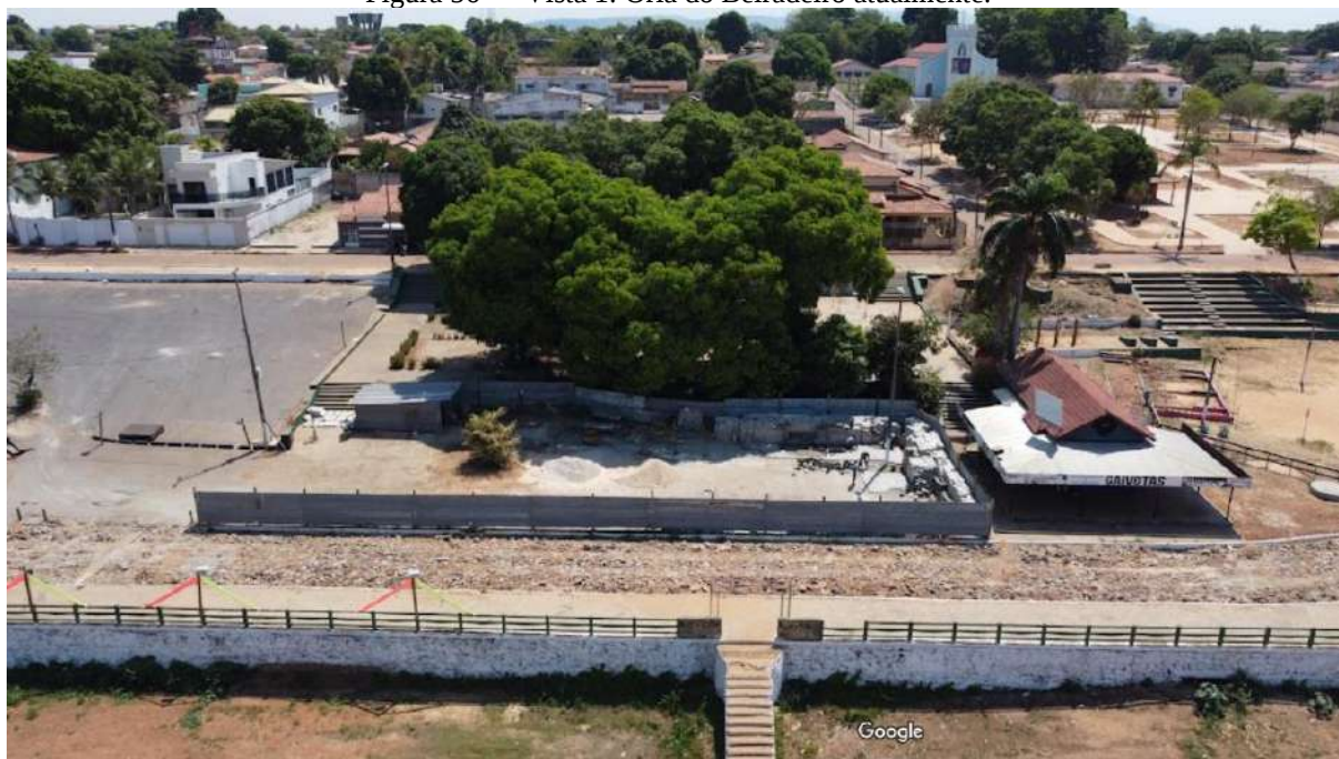
Figura 56 — Vista 1: Orla do Beiradeiro atualmente.
