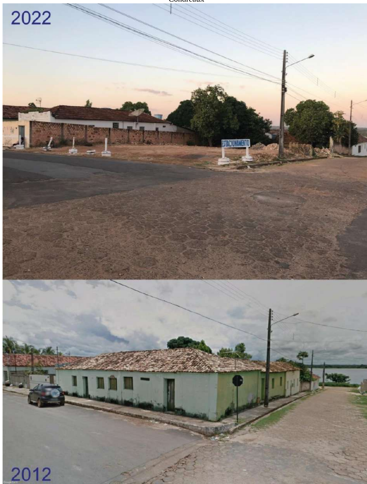
Figura 24 — Remoção Completa de Edificação no Cruzamento da Av. Couto Magalhães com a Rua Henry Condreaux
