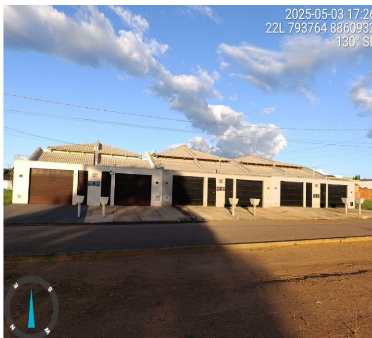
Figura 29: Padrão de construções encontrado no Setor Bertaville.
