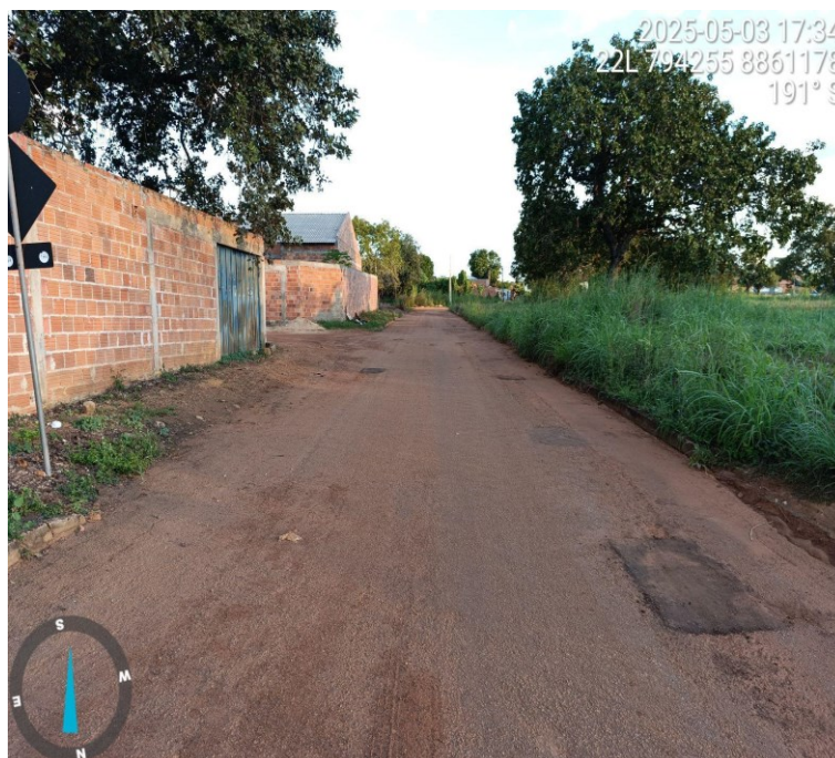
Figura 20: Manutenção preventiva e reparos periódicos no asfalto no Setor Bertaville.
