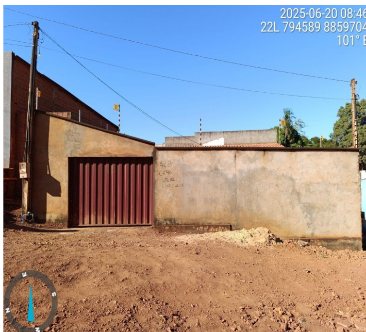
Figura 19: Unidades habitacionais encontradas no Setor Irmã Dulce com muro e reboco.
