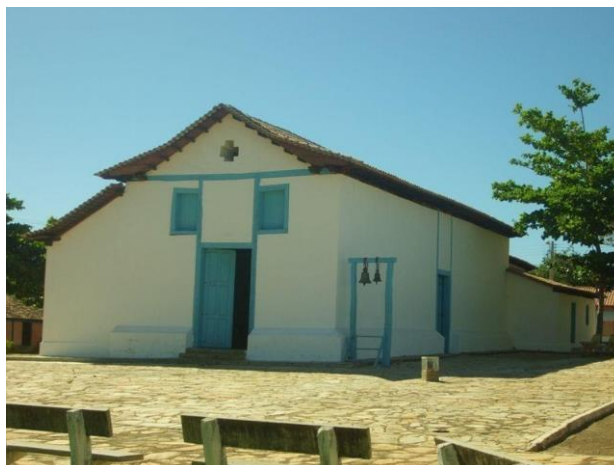
Figura 1- Igreja de Nossa Senhora do Carmo
