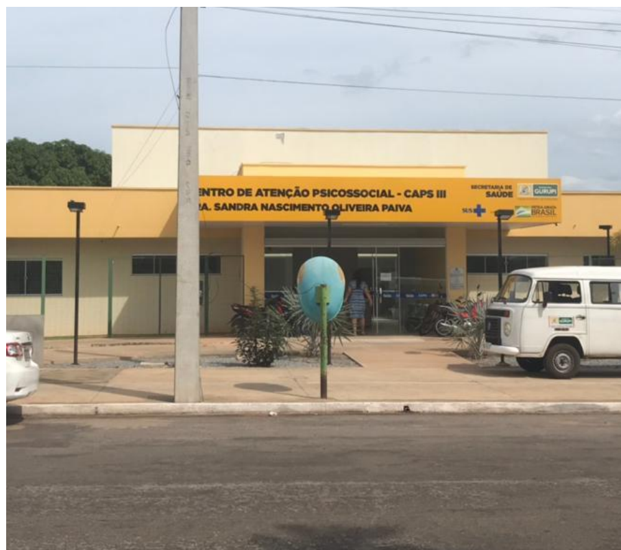
Figura 41: Fachada CAPS III em Gurupi-TO.
