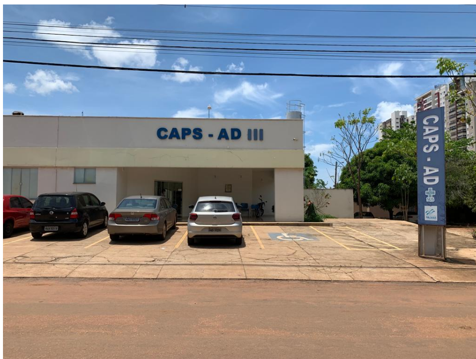
Figura 46: Fachada CAPS AD III em Palmas.
