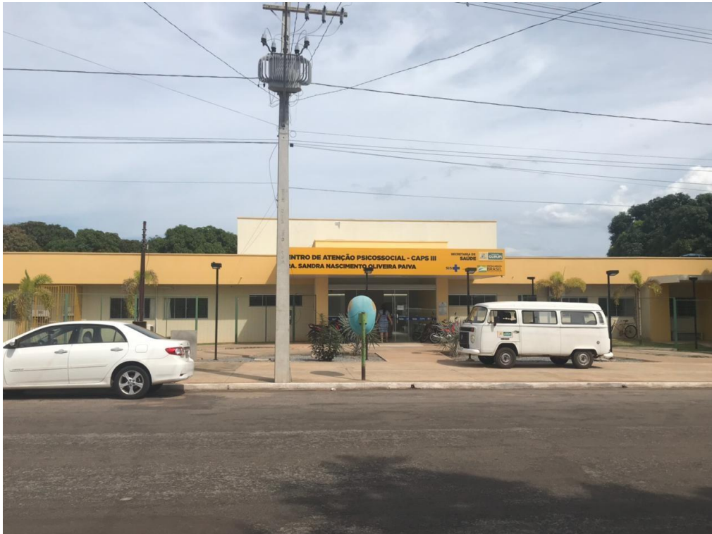
Figura 26 – Foto da fachada do CAPSIII
