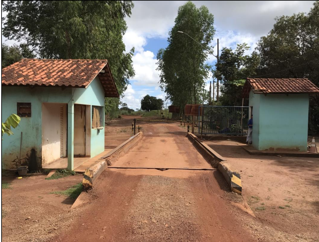
Figura 3 – Portaria de acesso do Aterro Sanitário de Palmas/TO vista de dentro para fora.
