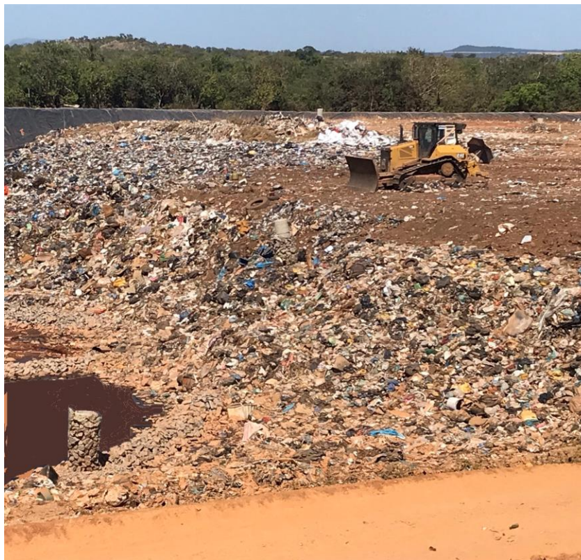
Figura 4 - Disposição dos resíduos no Aterro Sanitário de Palmas/TO.
