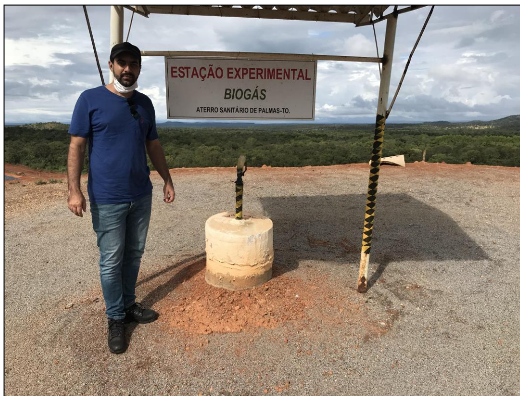
Figura 6 - Estação experimental de biogás do Aterro Sanitário de Palmas/TO.
