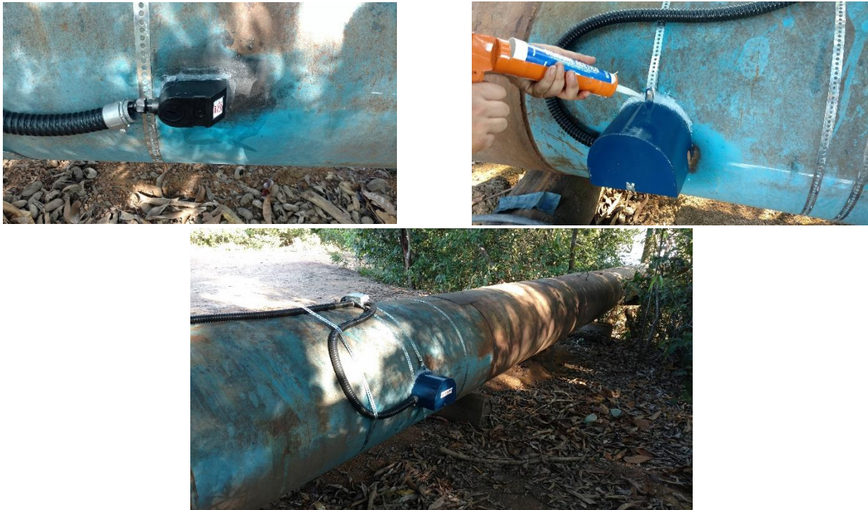
Figura 24. Fixação e vedação dos transdutores.
