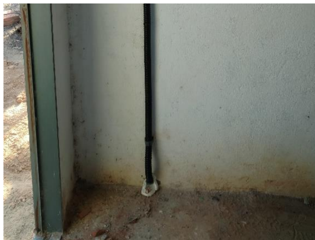
Figura 24. Furo no piso para passagem do conduíte.
