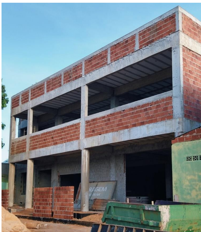
Figura 7: Alvenaria de vedação utilizando tijolos cerâmicos.
