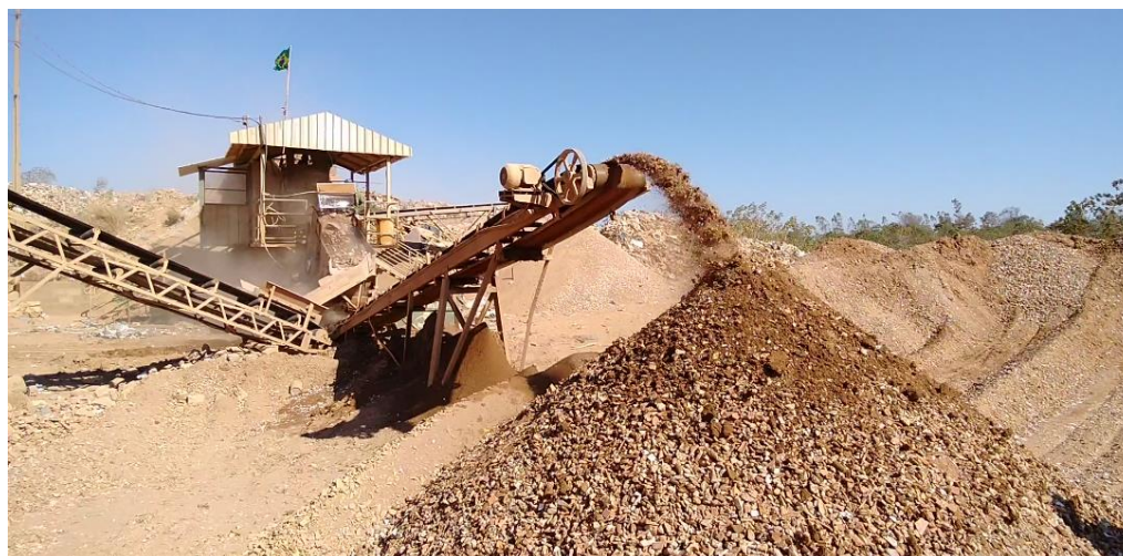
Figura 11: Resíduo de construção civil pós-processamento.
