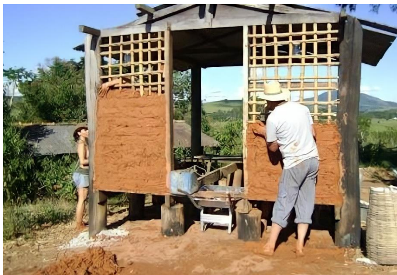
Figura 3: Execução da parede de pau-a-pique.
