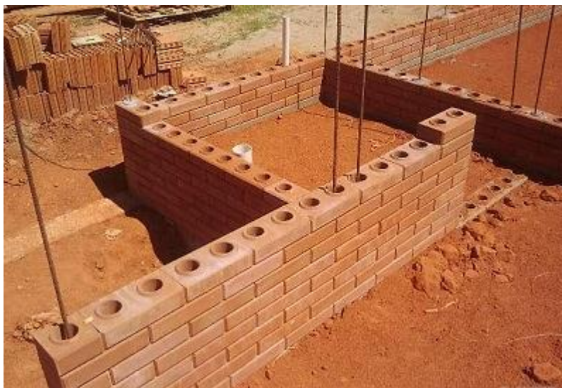
Figura 8: Alvenaria de vedação utilizando tijolos de solo-cimento.
