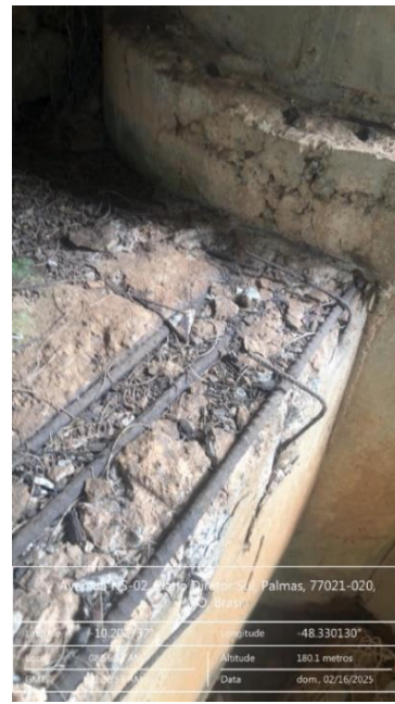
Figura 79 – Armadura exposta
