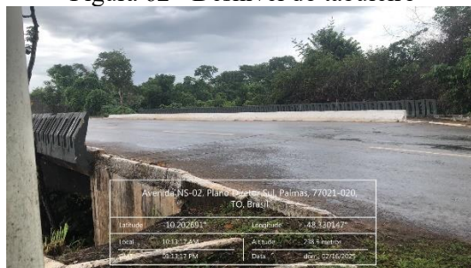
Figura 62 - Desnível do tabuleiro
