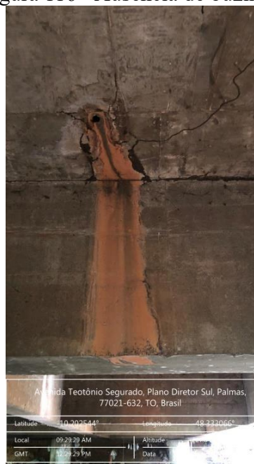
Figura 116 - Ausência de buzinode
