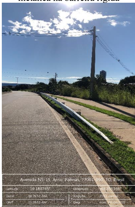
Figura 361 - Implantação de transição metálica na barreira rígida
