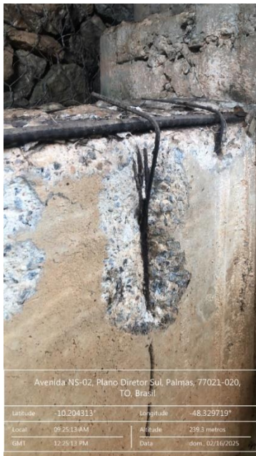
Figura 78 – Armadura rompida
