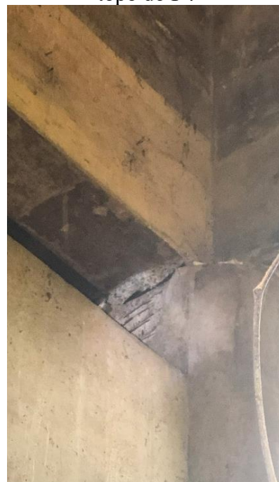
Figura 88 - Exposição de armadura no topo do P4
