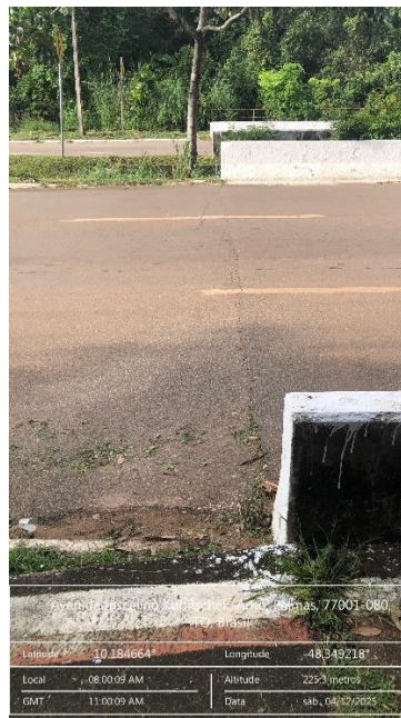
Figura 193 - Trinca na cabeceira Leste
