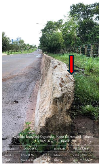
Figura 106 - Exposição de pontas de armadura
