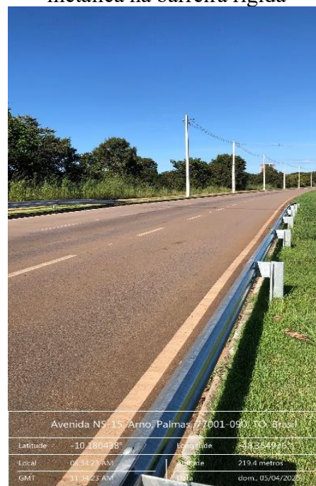
Figura 362 - Implantação de transição metálica na barreira rígida
