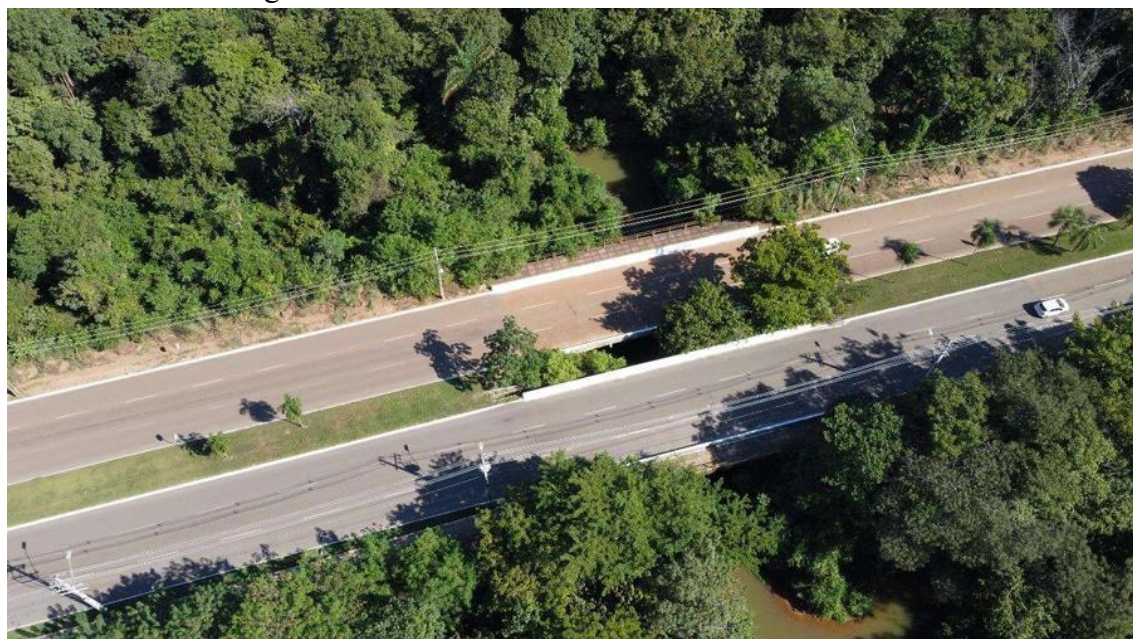
Figura 188: Pontes da Avenida Juscelino Kubitschek
