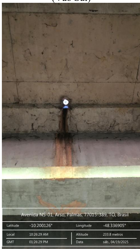
Figura 282 - Mancha na Longarina 05 (Vão Sul)
