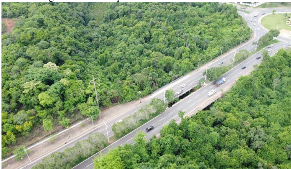
Figura 12 – Vista superior das Pontes da Avenida NS-02
