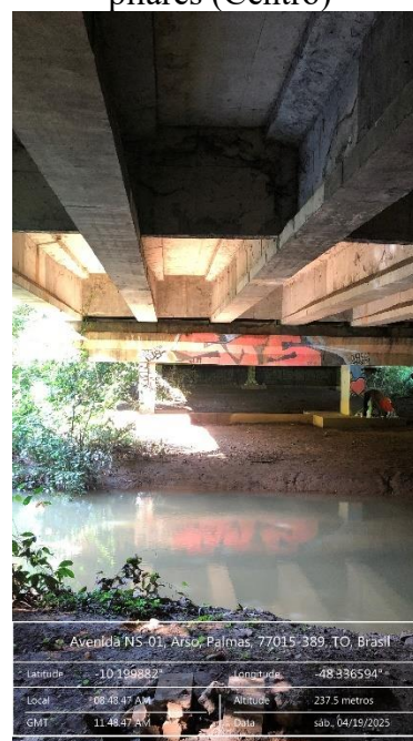
Figura 264 - Disposição de vigas e pilares (Centro)
