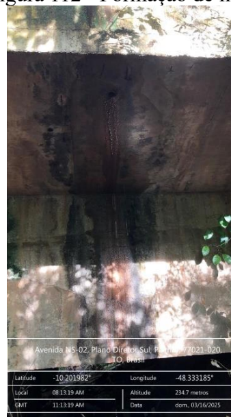
Figura 112 - Formação de limo
