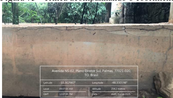
Figura 75 - Trinca acompanhando o cobrimento
