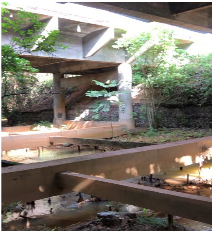
Figura 13 – Vigas de travamento primárias e secundárias
