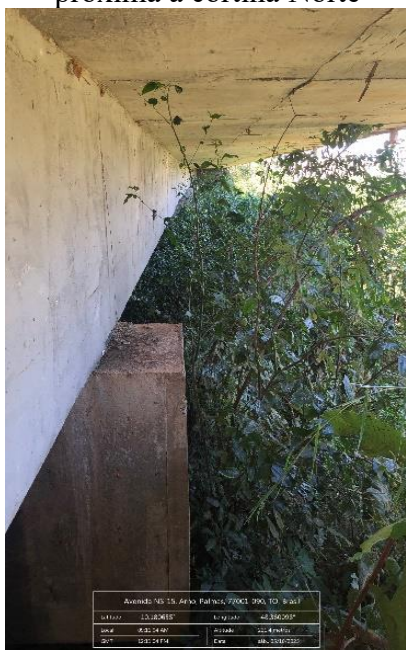
Figura 391 - Densidade de vegetação próxima à cortina Norte
