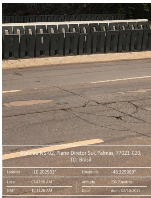
Figura 14 - Desgaste superficial
