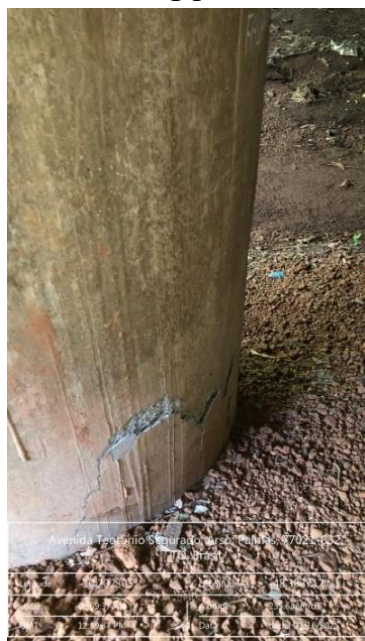
Figura 122 - Indício de deslocamento no P1
