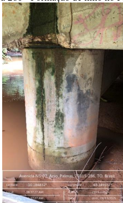
Figura 260 - Formação de limo no Pilar 04
