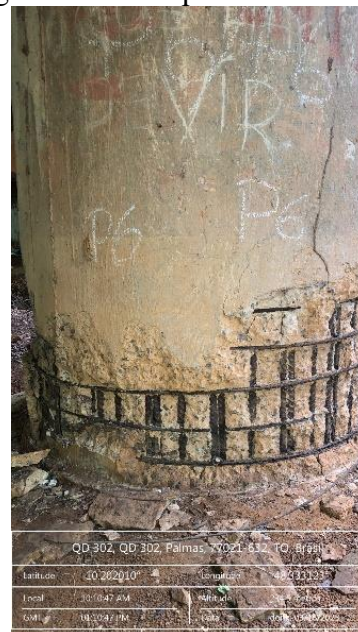
Figura 127 - Deslocamento no P6
