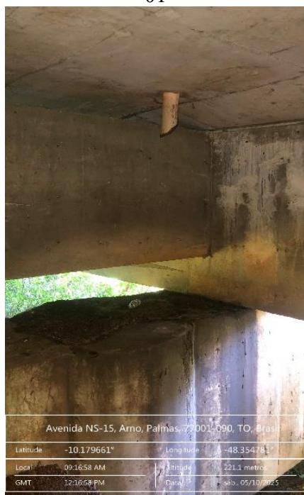
Figura 420 - Buzinote acima da travessa 01
