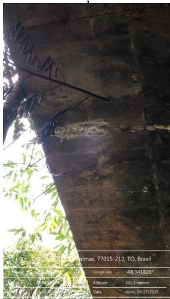
Figura 333 - Formação de estalactite no balanço Sul
