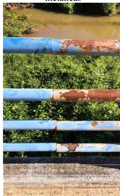
Figura 390 - Seccionamento de barras metálicas
