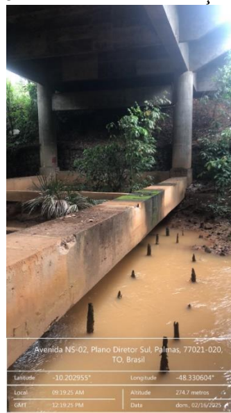
Figura 84 – Umidade e formação de limo
