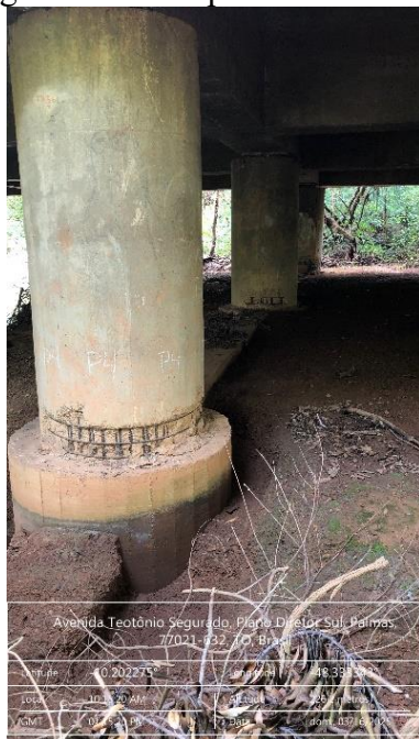
Figura 124 - Deslocamento no P4
