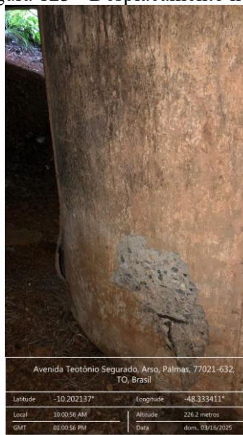
Figura 123 - Deslocamento no P2
