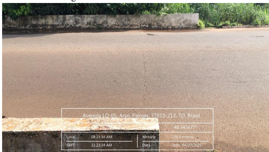
Figura 330 - Trinca na cabeceira Leste
