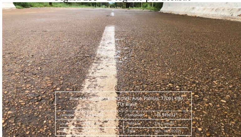
Figura 233 - Desgaste por abrasão
