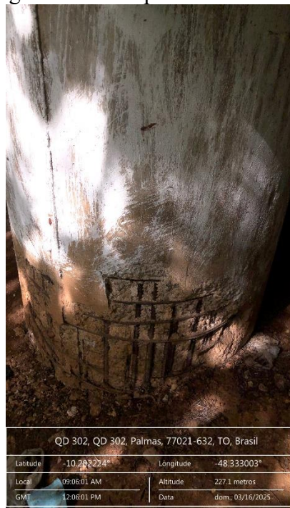
Figura 132 - Deslocamento no P9
