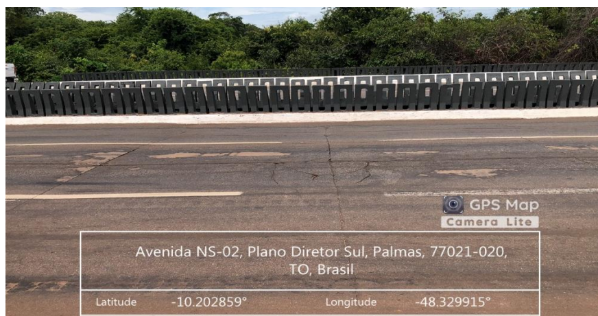
Figura 16 - Desgaste superficial
