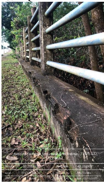
Figura 139 – Quebra do Material de Base
