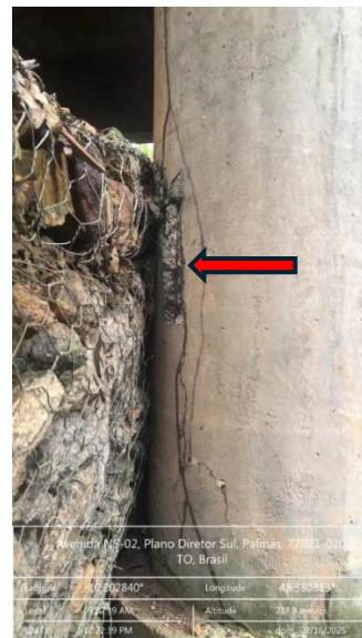
Figura 86 - Deslocamento e exposição de armadura no P1
