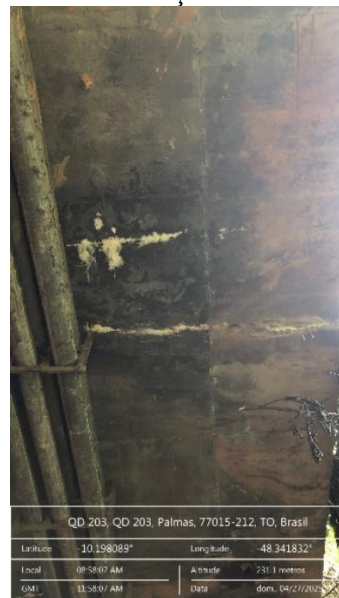
Figura 334 - Formação de estalactite no balanço Sul
