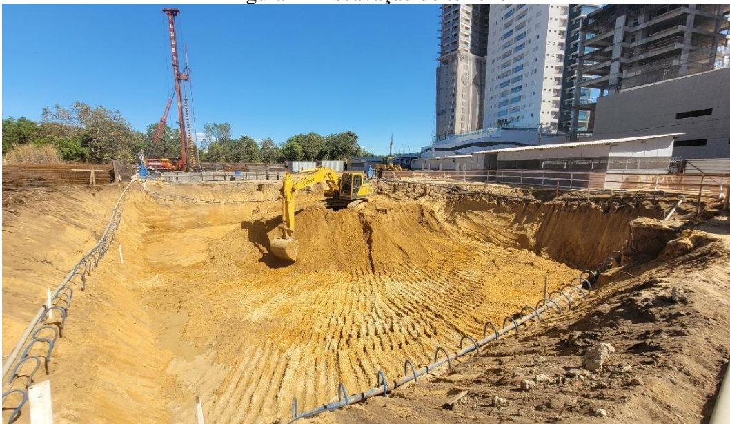
Figura 2 - Escavação do terreno
