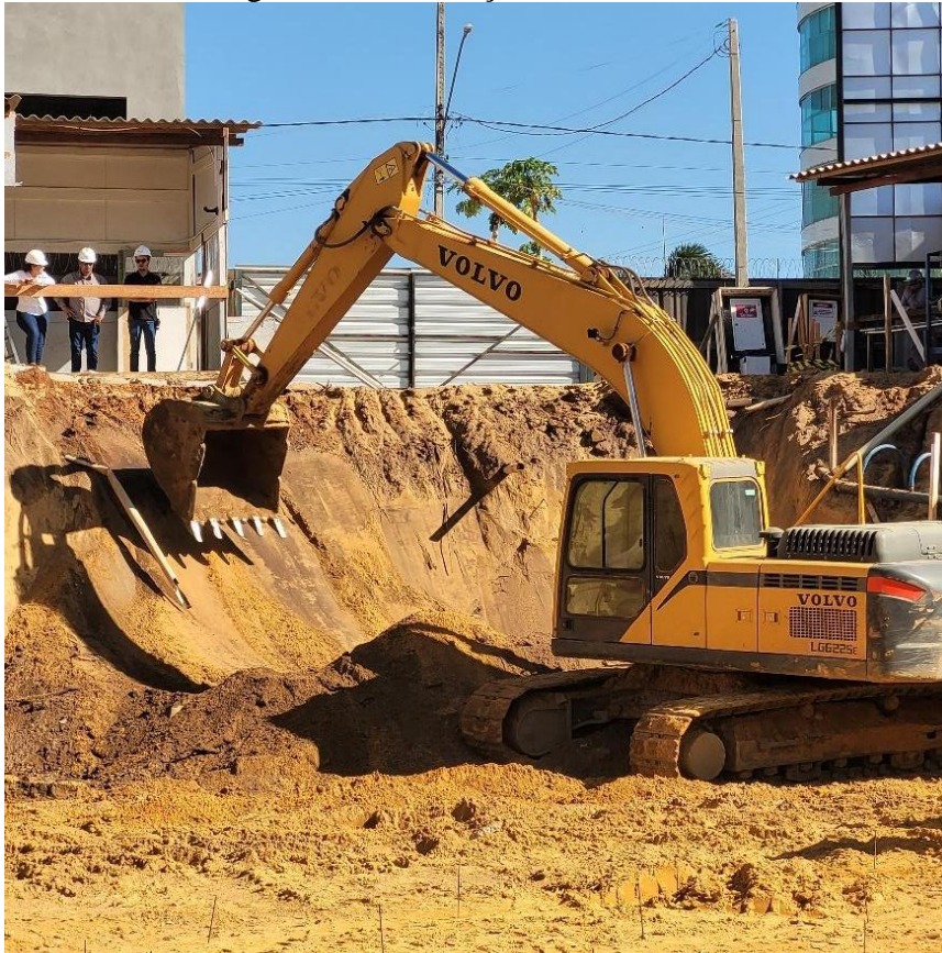
Figura 17 - Escavação e taludamento
