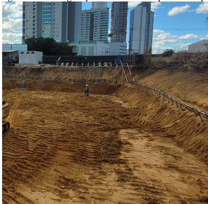
Figura 20 - Configuração final do talude pós escavação
