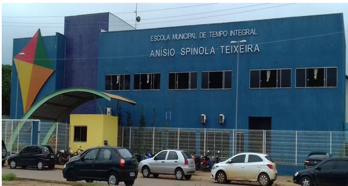
Figura 5 - Vista parcial da Escola Municipal de Tempo Integral (ETI) Anísio Spínola Teixeira, Setor Bertaville, Palmas (TO).
