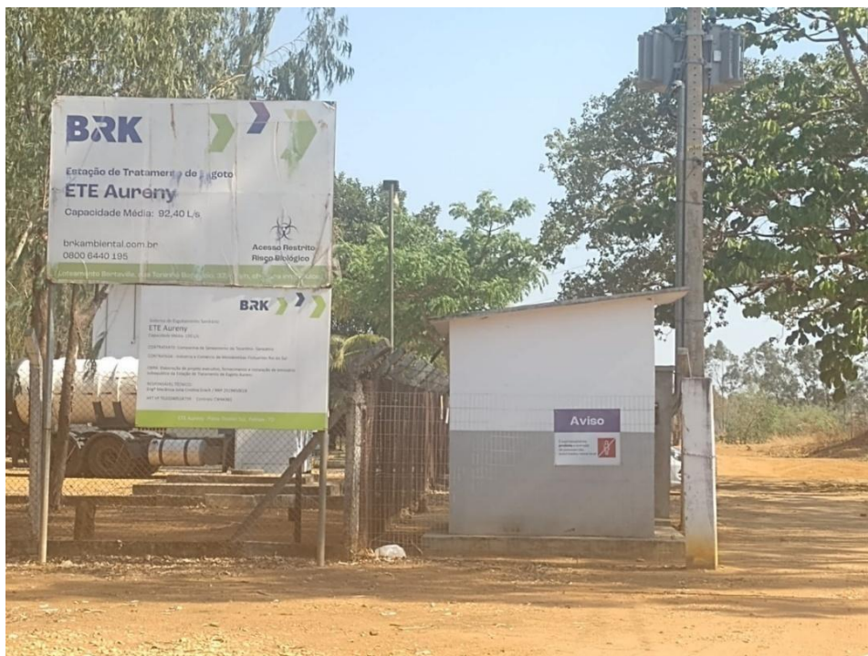
Figura 7 – Estação de Tratamento de Esgoto Aurenry, Setor Bertaville, Palmas (TO).
