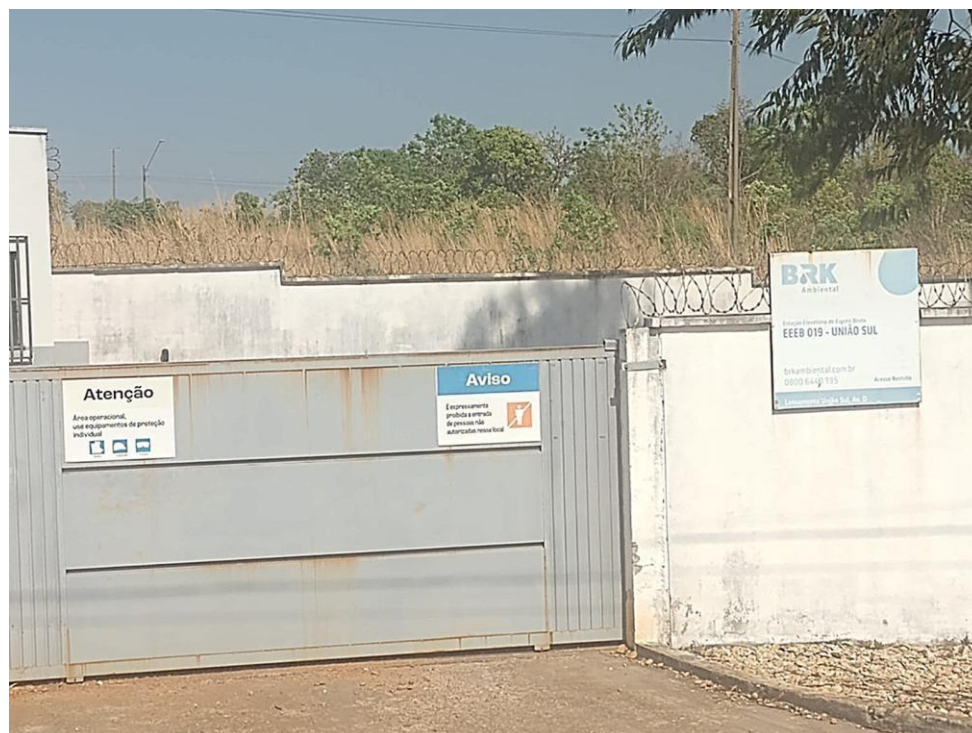
Figura 8 – A Estação Elevatória de Esgoto União Sul, no Setor União Sul, em Palmas (TO).
