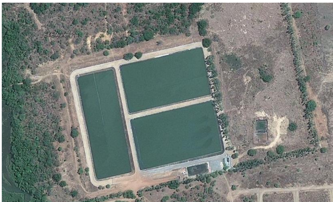
Figura 10 - Vista aérea das lagoas de estabilização em série da ETE Aurenny, Setor Bertaville, Palmas (TO).
