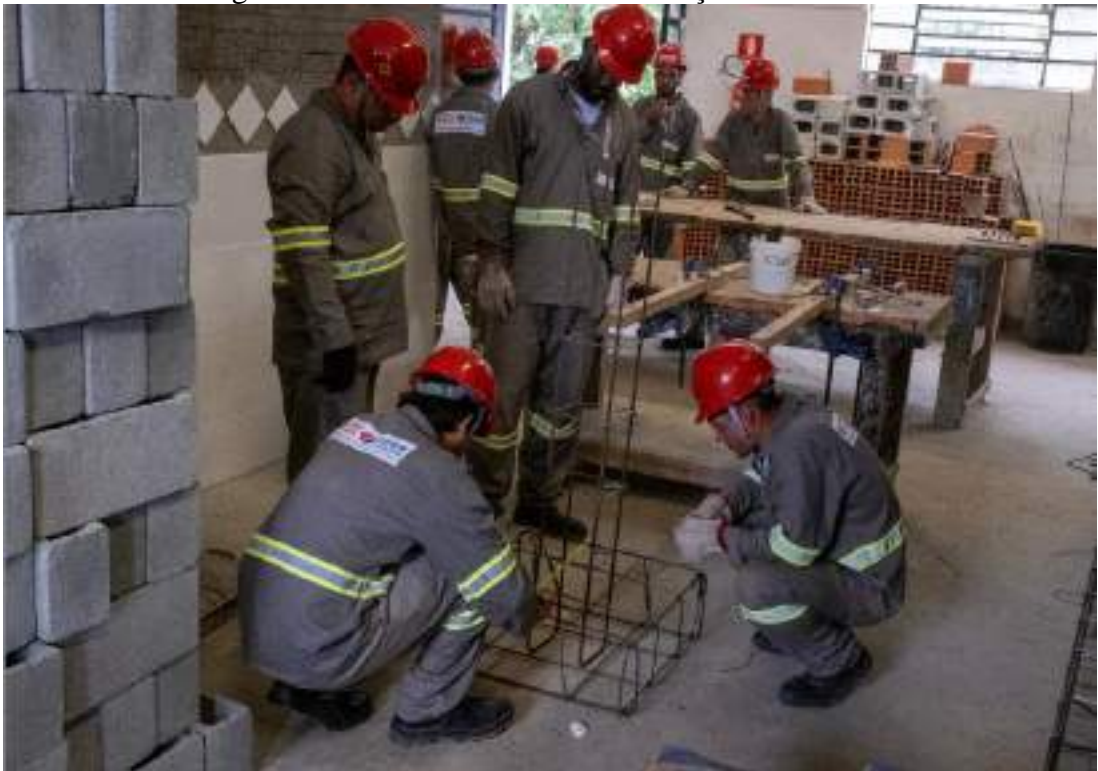
Figura 5 - Atividade do curso de armação de concreto
