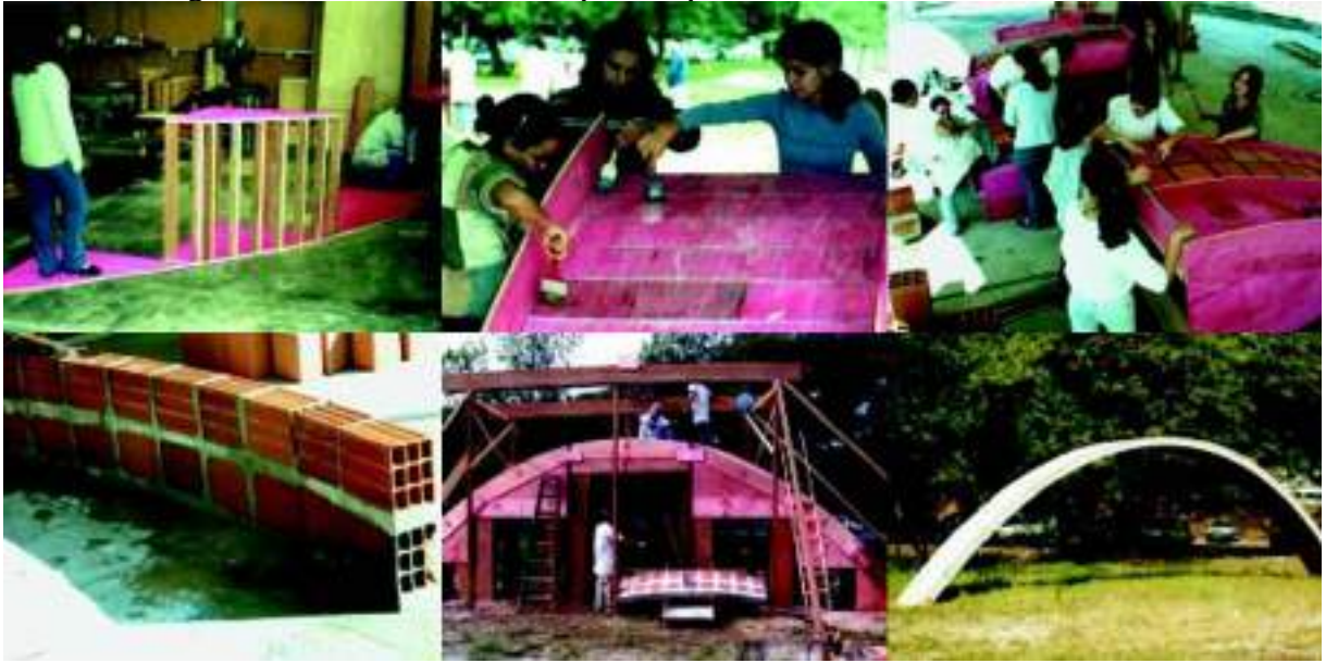
Figura 9 - Oficina de arco em painéis pré-moldados de cerâmica armada
