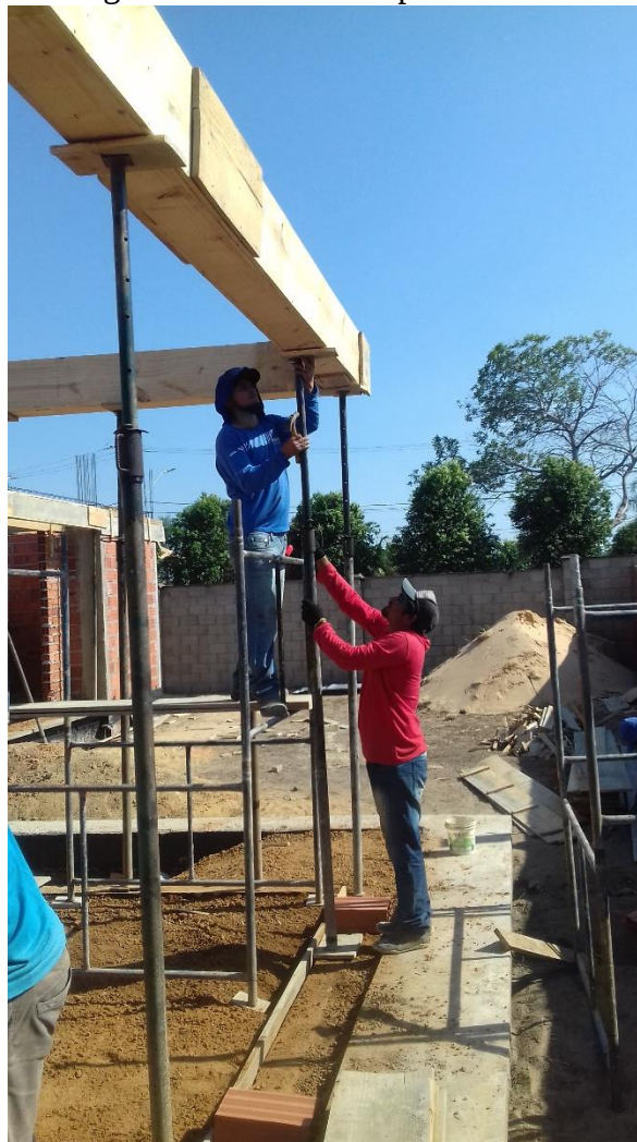
Figura 10 – Montagem de escoramento para formas de viga na obra 1
