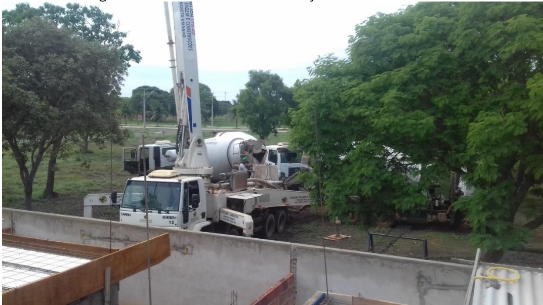
Figura 14 - Caminhões bomba-lança e betoneira na obra 5
