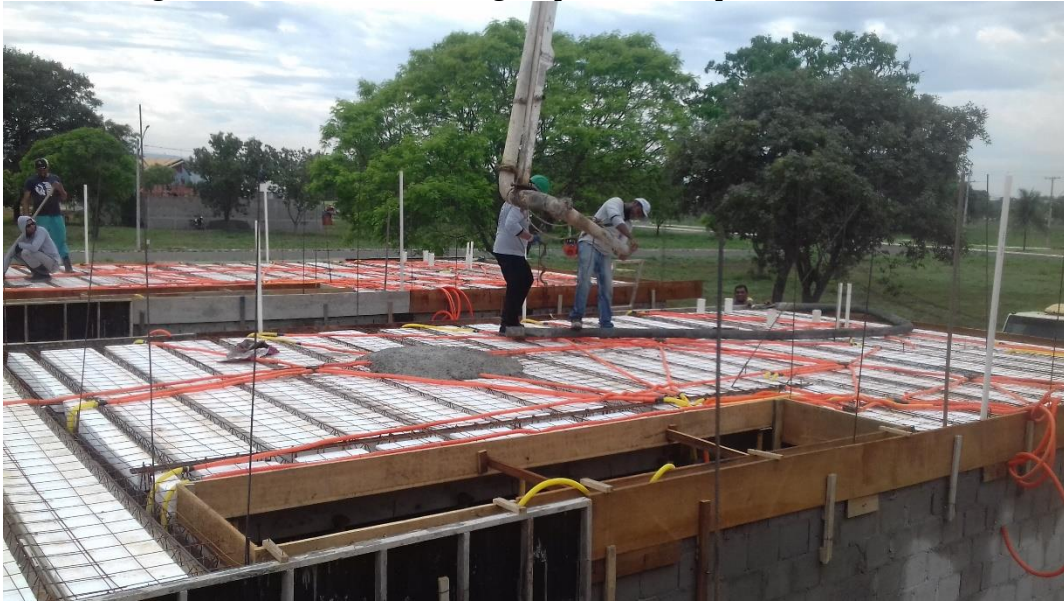
Figura 18 – Retirada do mangote para desentupimento na obra 5
