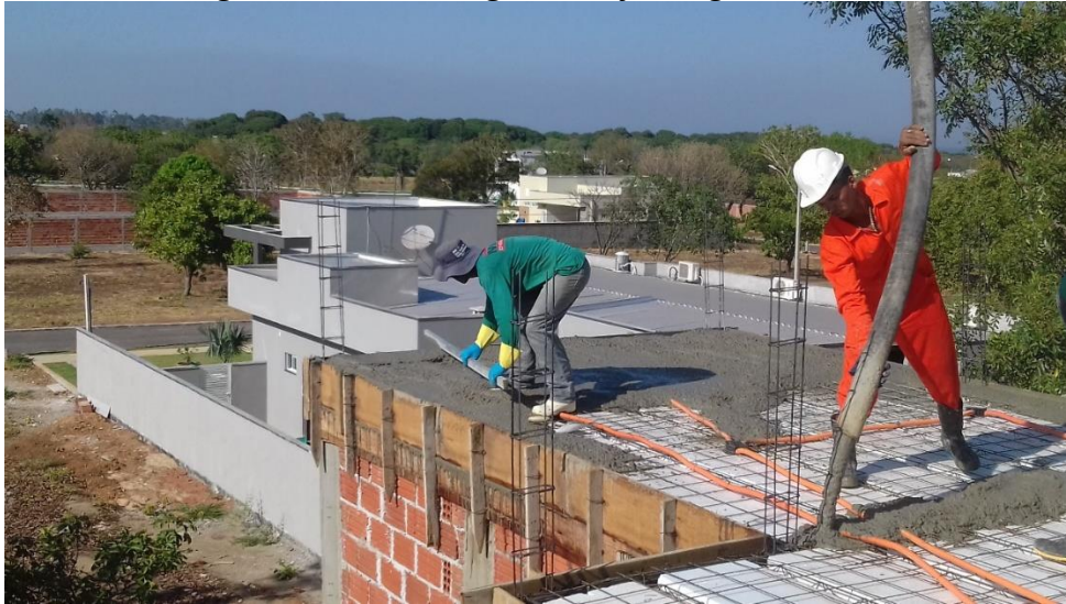
Figura 15 – Concretagem de laje e vigas da obra 2
