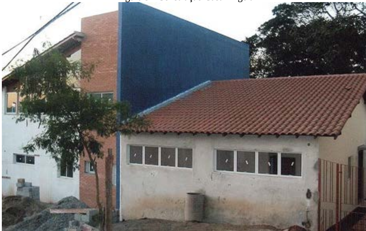
Figura 9 - Construção Casa Angela
