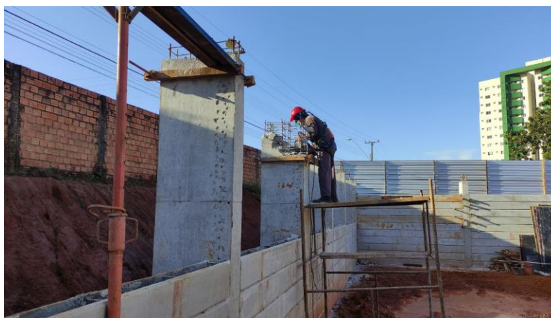
Figura 7 – Demolição parte superior do pilar
