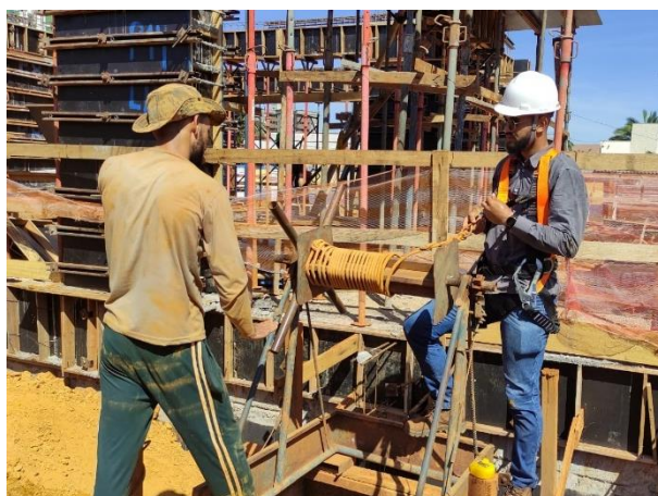
Figura 24 – Conferência da escavação do tubulão
