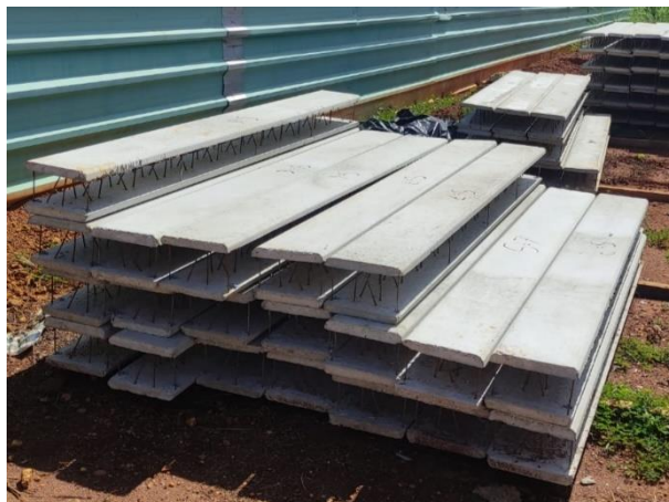
Figura 16 - Armazenamento de painéis para execução do muro de arrimo
