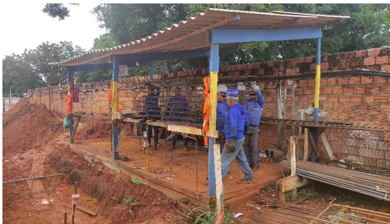
Figura 8 – Central de armação
