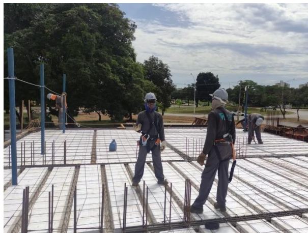
Figura 39 – Colaboradores usando equipamentos de proteção individual
