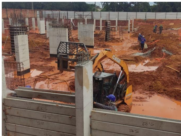
Figura 31 - Muro de arrimo em execução
