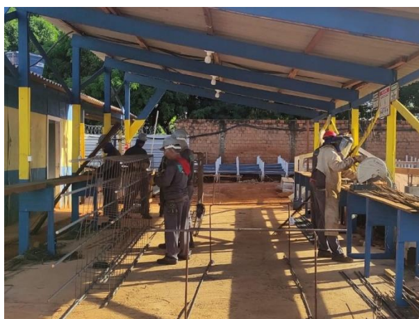
Figura 30 - Corte e dobra do aço na obra
