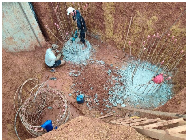
Figura 6 – Demolição de tubulões
