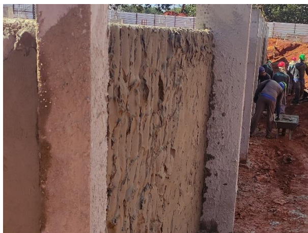
Figura 18 - Execução do reboco do muro de arrimo com argamassa estabilizada
