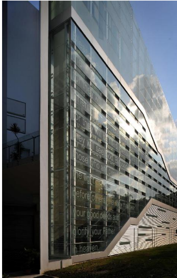
Figura 37- Destaque para a ventilação da BETHEL ASSEMBLY OF GOD Fonte: ( https://archello.com/project/bethel-assembly-of-god )
