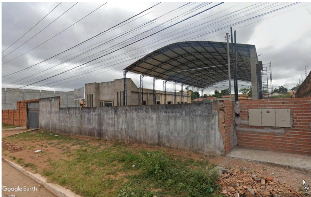
Figura 40- Imagens da construção do templo da assembleia de Deus em Imperatriz/MA Fonte: Acervo pessoal
