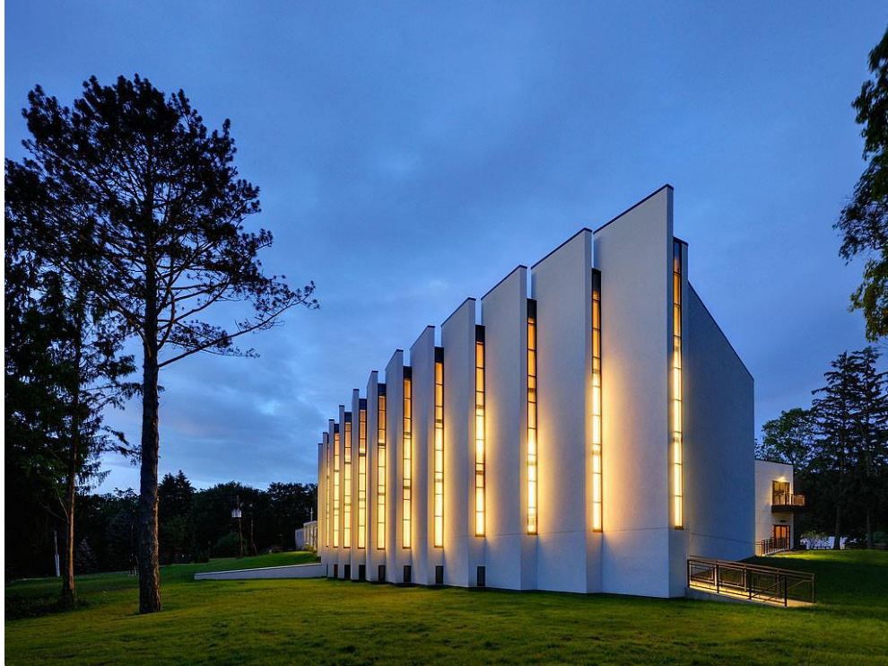
Figura 32- Imagem da bela estrutura da igreja presbiteriana Coreana
