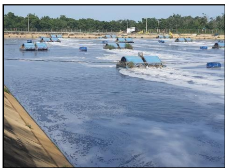
Figura 10: Lagoa Aerada com 16 aeradores que trabalham alternadamente.
