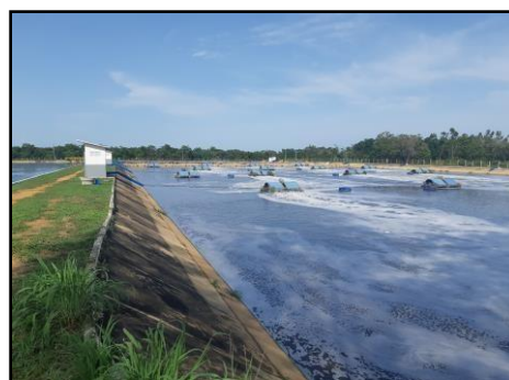
Figura 11: Falta placas de identificação do processo.
