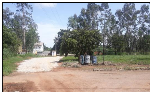
Figura 25: Ausência de sinalização de indicação ao acesso da ETE.
