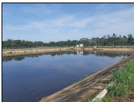
Figura 12: Vista geral da Lagoa de maturação e última do processo de tratamento por lagoa.
