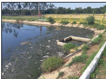
Figura 8: Presença de material grosseiro (sacolas plásticas, copos descartáveis) na saída da Lagoa Anaerobia para a Lagoa Aerada.
