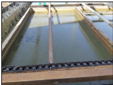
Figura 17: Vista superior de Flotador por Ar Dissolvido (FAD).
