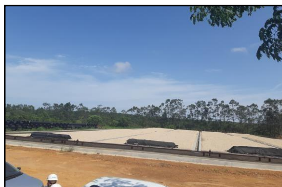
Figura 23: Vista as obras de instalação do patio de Geobags como destinação do lodo gerado na ETE.
