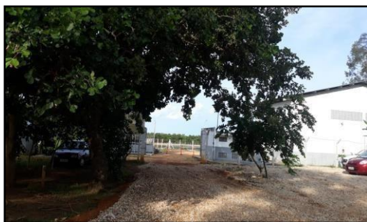
Figura 24: Ausência de identificação na entrada da ETE e informações de alerta para entrada de pessoas não autorizadas.
