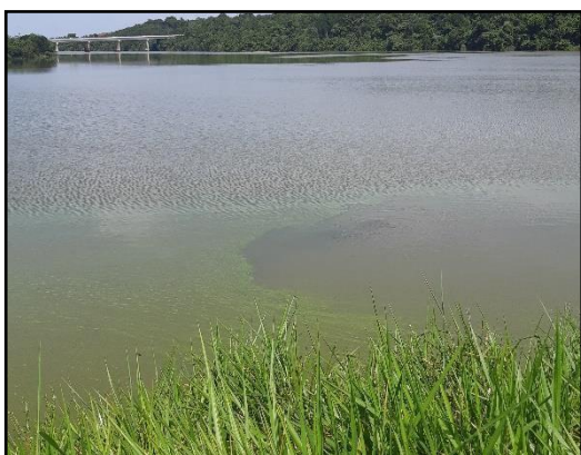
Figura 21: Local do lançamento de efluente tratado no Lago UHE Luis Eduardo e área da zona de mistura.
