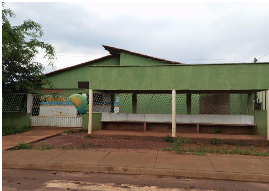
Figura 8 Escola municipal construída no assentamento
