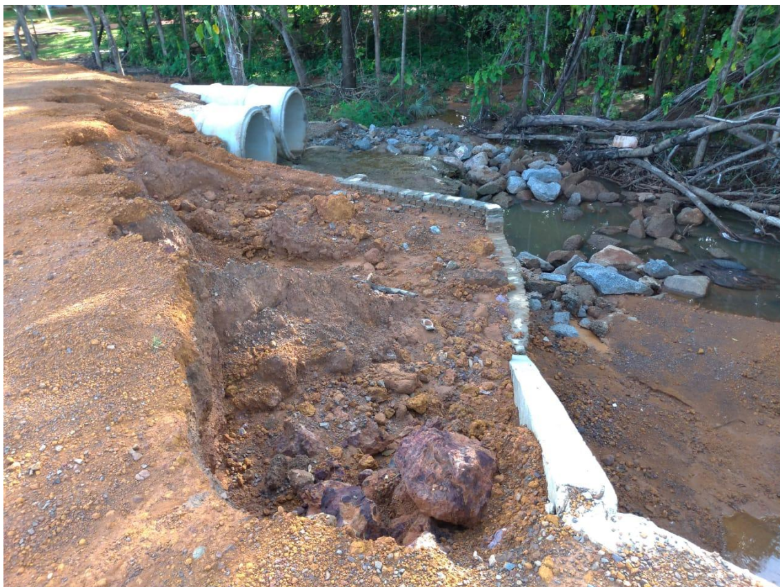
Figura 5 - Erosões e assoreamento causados pelo sistema de drenagem instalado sobre o Córrego Suçuapara no trecho da construção da ponte da Avenida NS-04.
