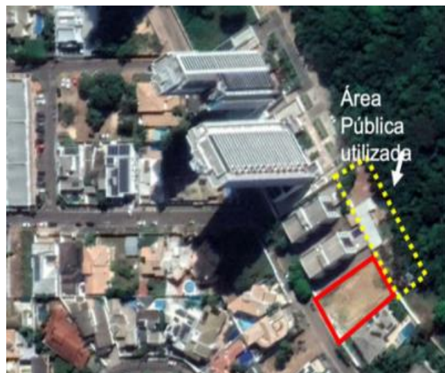
Figura 24 - Vista superior que demonstra a utilização inadequada dos tapumes em área pública
