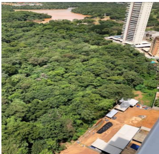
Figura 23 - Vista superior que demonstra a utilização inadequada dos tapumes em área pública
