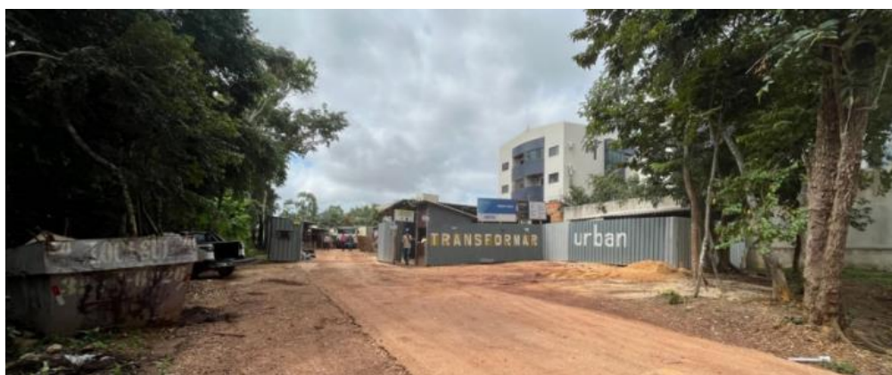
Figura 22 - Colocação dos tapumes em área pública
