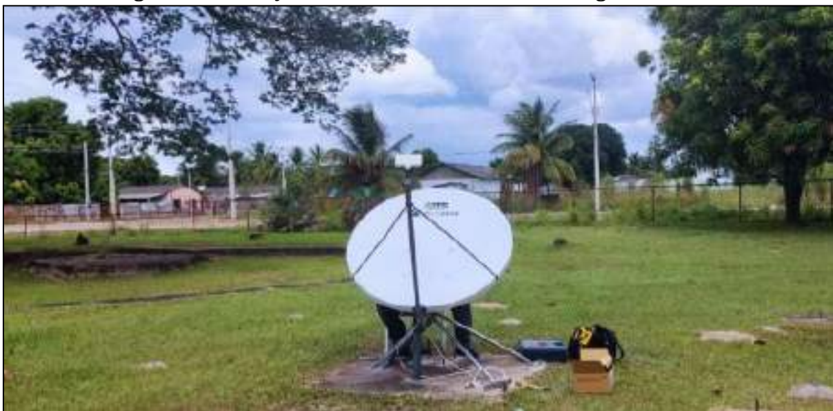
Figura 6: Instalação de Antena GEO SGDC do Programa Gesac
