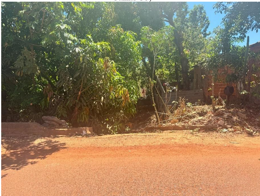
Figura 32 – Edificação próximo encosta do Córrego Machado (Aureny II e Saramandaia, Palmas-TO)
