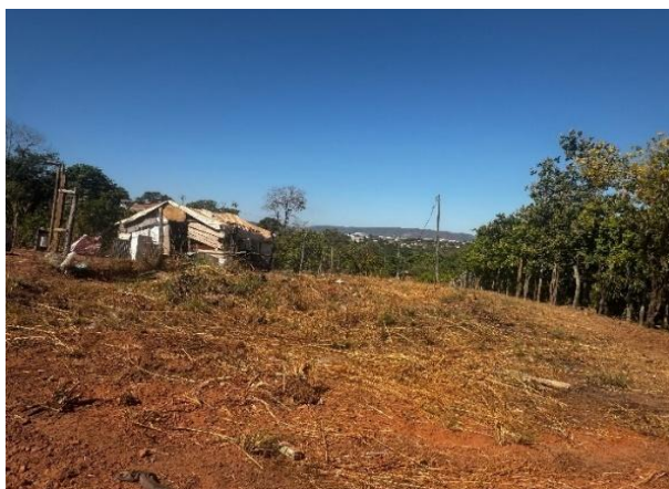
Figura 14 – Habitação no NUI Setor Machado Oeste, Palmas-TO
