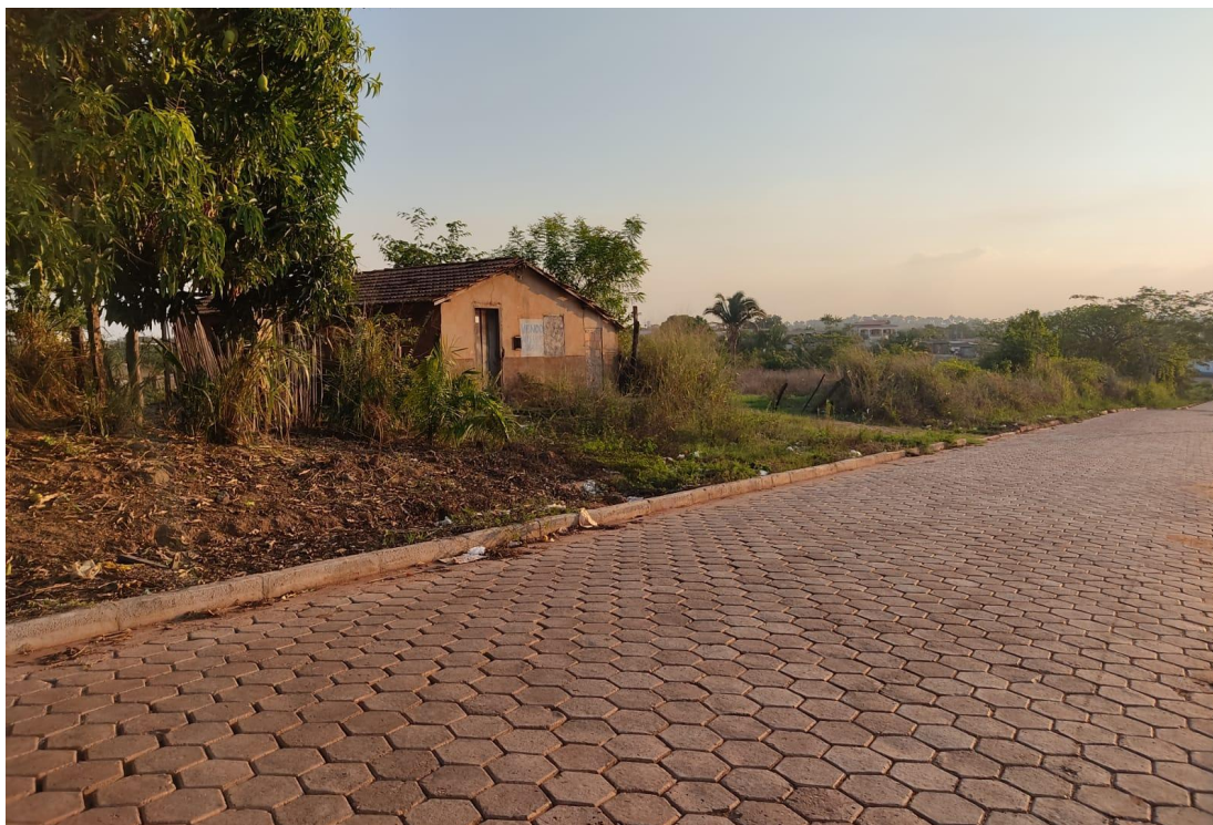
Figura 18 - Empreendimento Agrícola Urbano 4. Pavimentação em blocos Sextavados na rua de acesso a mesma.
