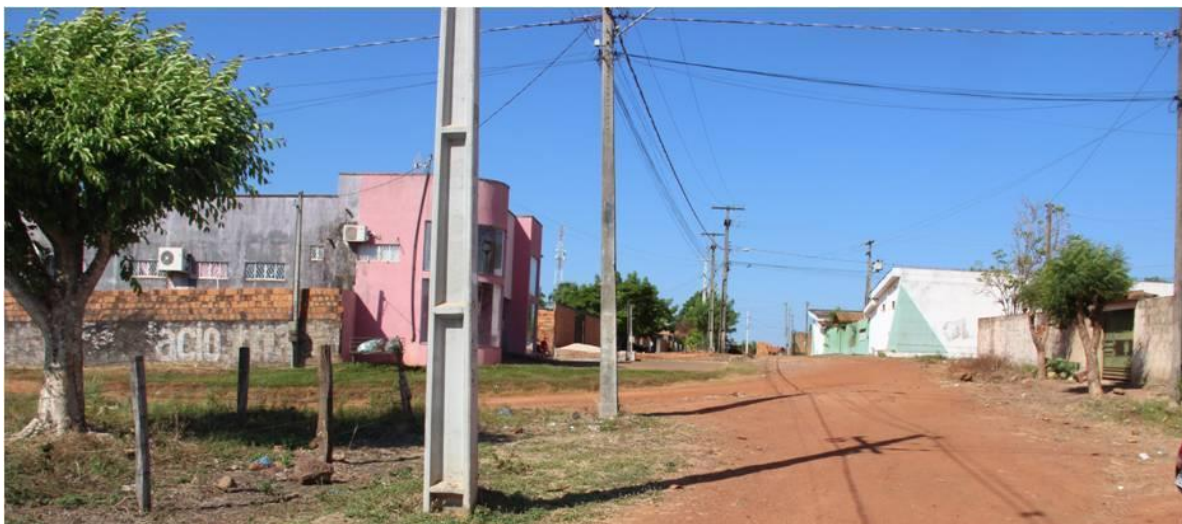
Figura 4 - Bairro Centro com ruas sem Pavimentação Asfáltica.
