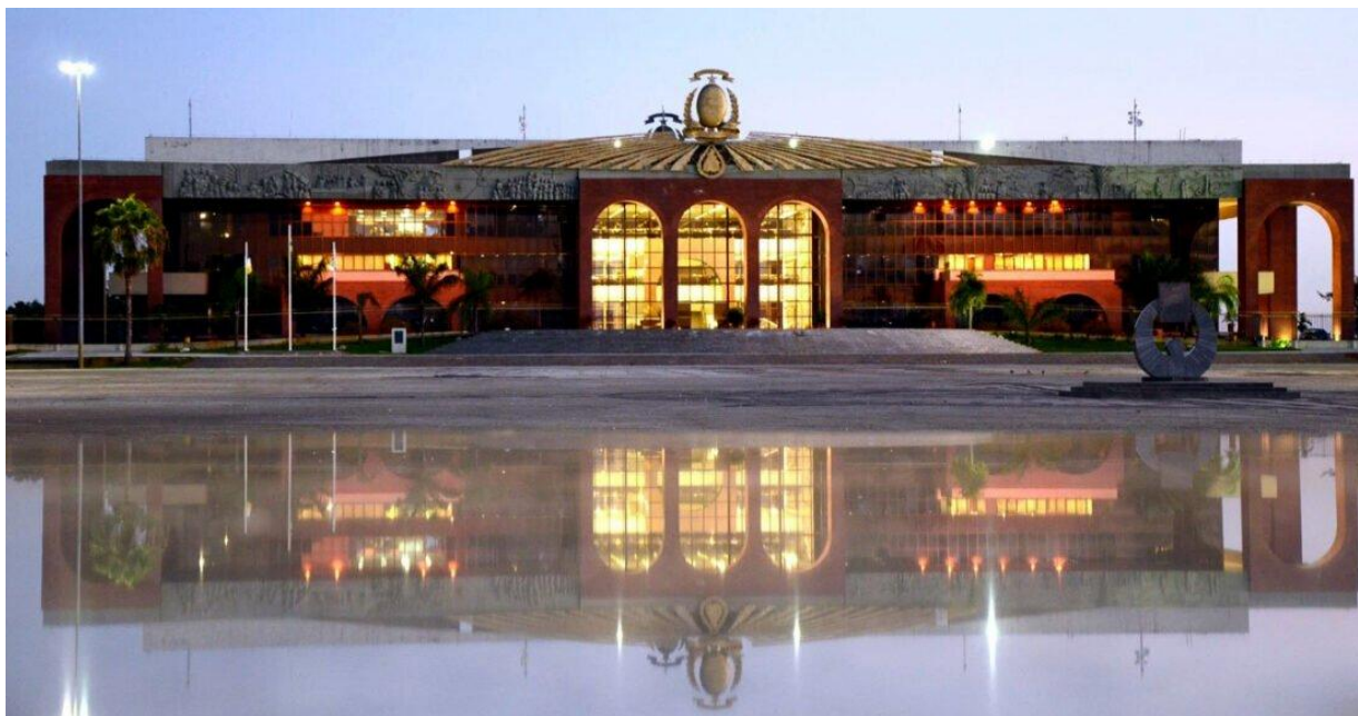
Figura 19 - Palmas. Edifício Monumental do Palácio Araguaia Governador José Wilson Siqueira Campos
