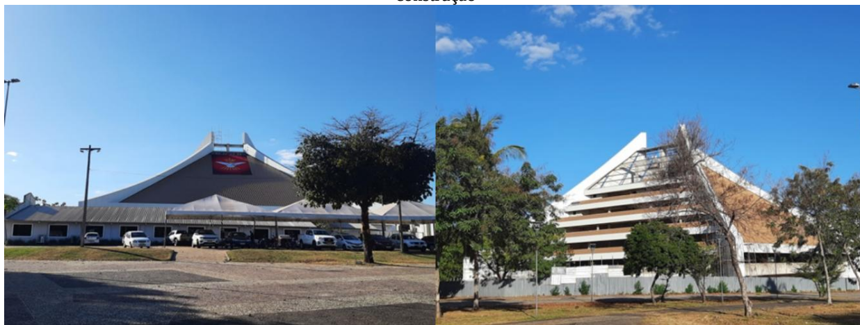
Figura 12 - Palmas. Edifício monumental da Catedral Católica do Divino Espírito Santo, em fase final de construção
