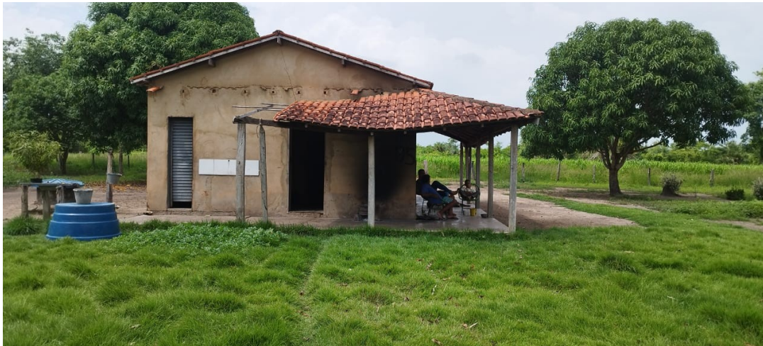
Figura 22: Casa dentro do lote, assentamento Palmares, 2023.
