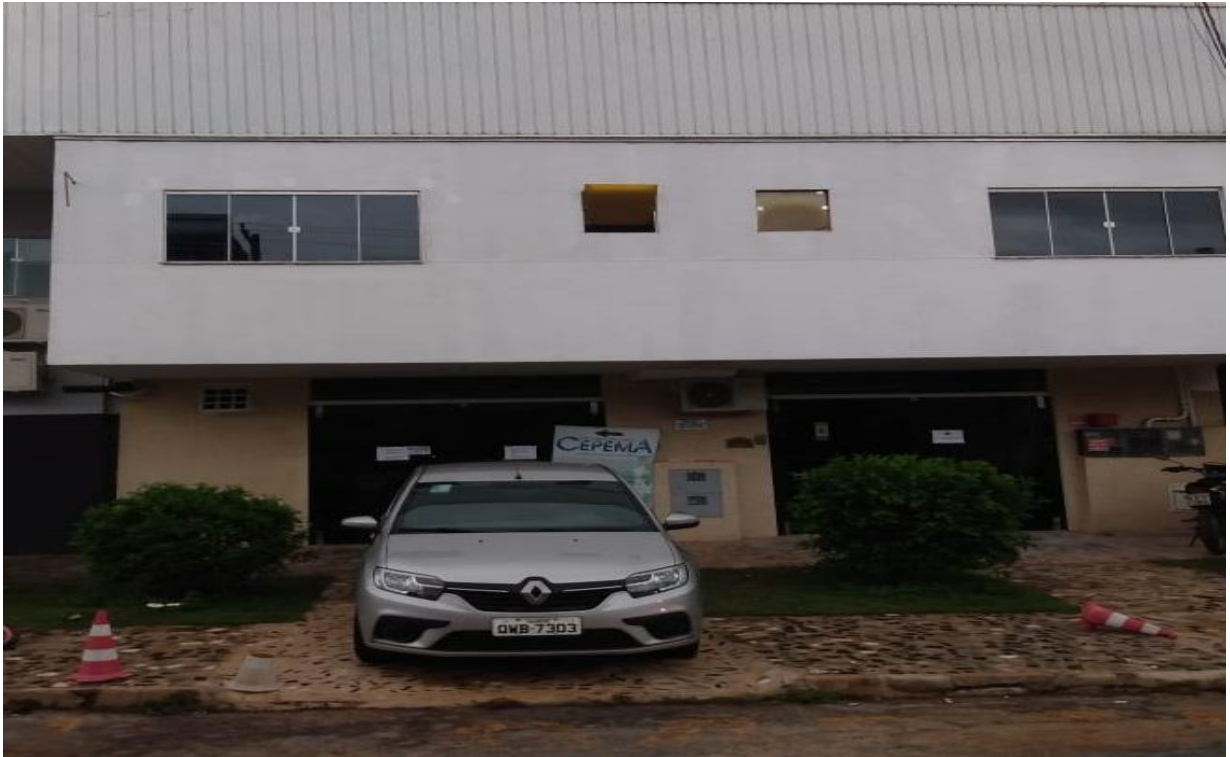
Figura 2 - Fachada da Cepema de Palmas
