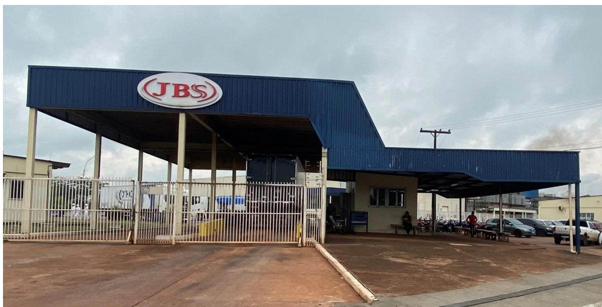
Figura 1 – Fachada da JBS – Unidade de Araguaína – Tocantins
