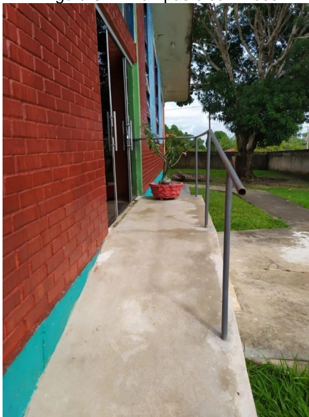
Figura 04 – Rampas e corrimões
