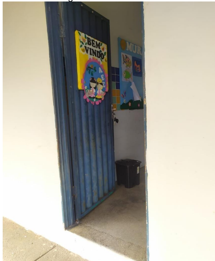
Figura 02 – Sala de AEE
