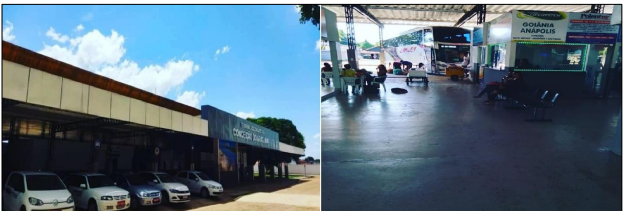
Figura 11 – Terminal Rodoviário de Conceição do Araguaia – PA
