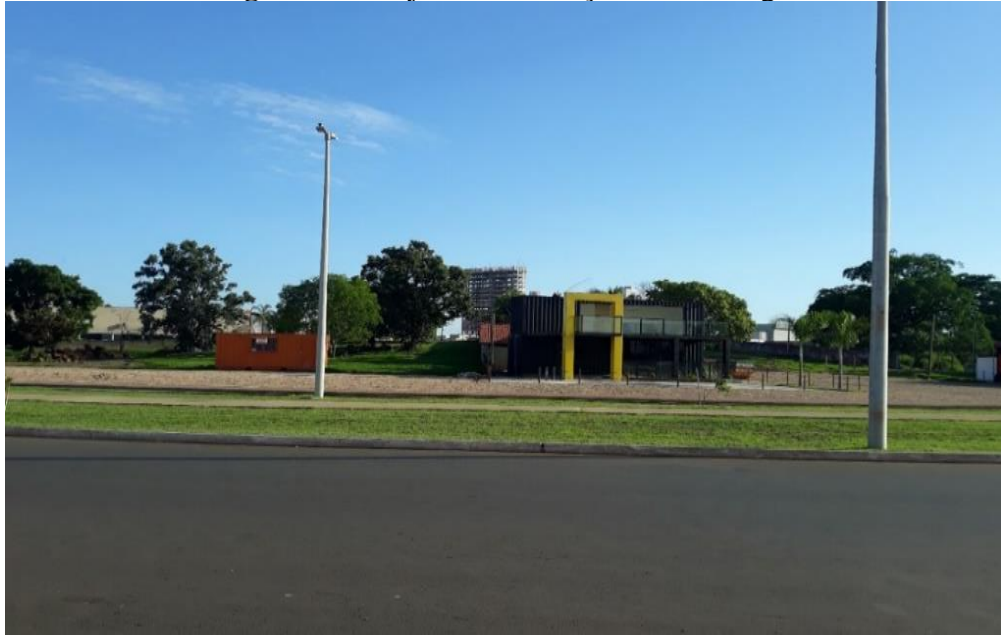
Figura 16 - Loja em construção na Via Lago
