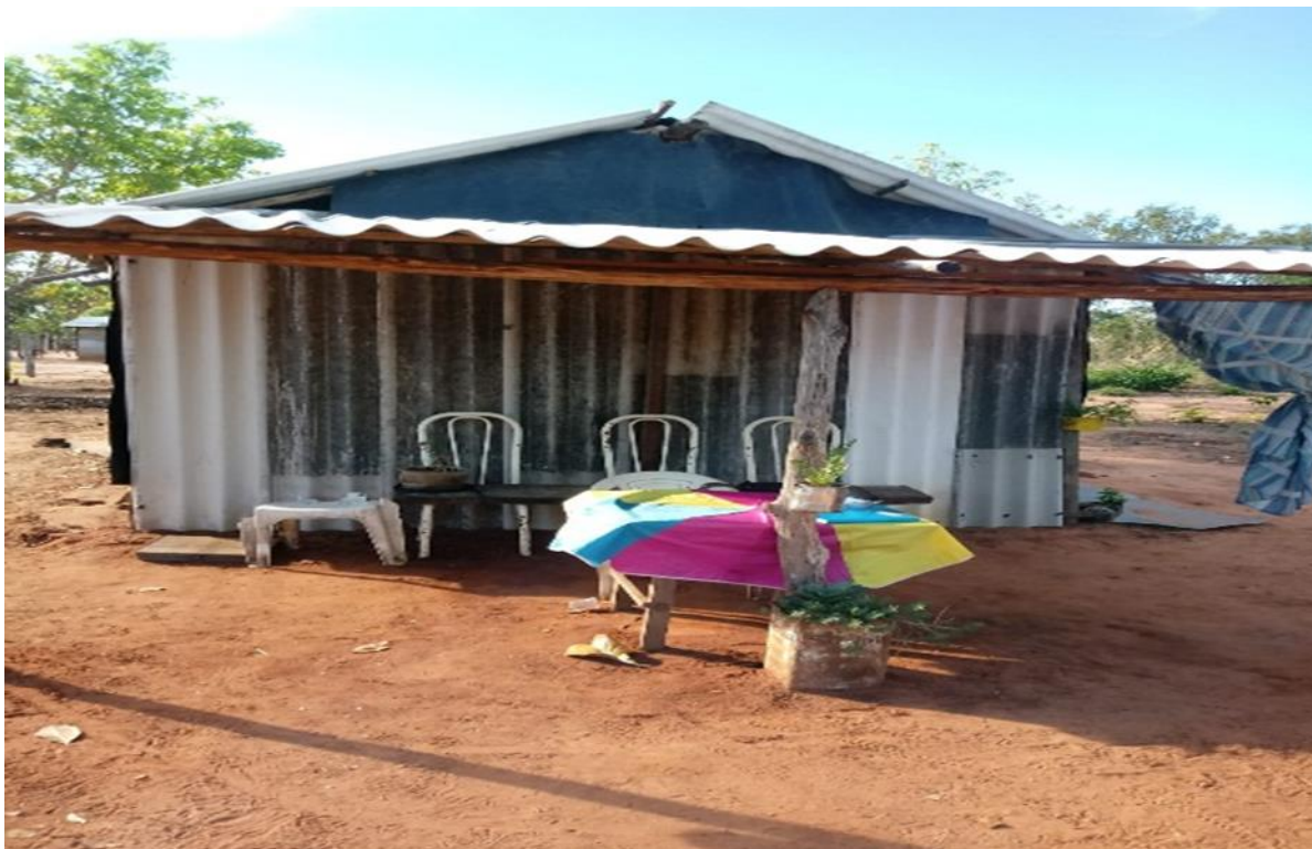
Figura 6 – Estrutura de casa na comunidade do Garavelos
