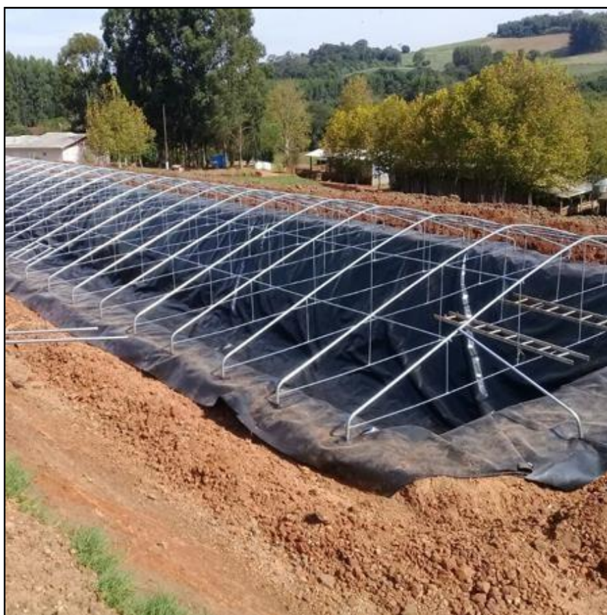
Figura 6- cisterna de lona em construção.
