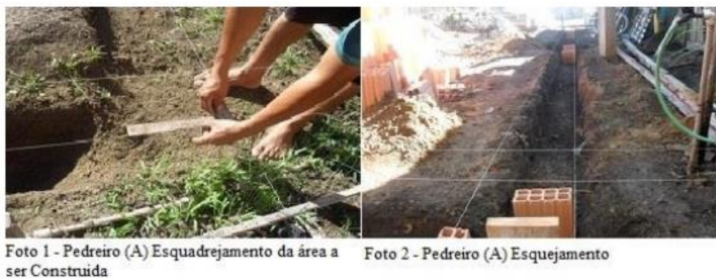
Figura 2 - Esquadrejamento da área a ser construída
