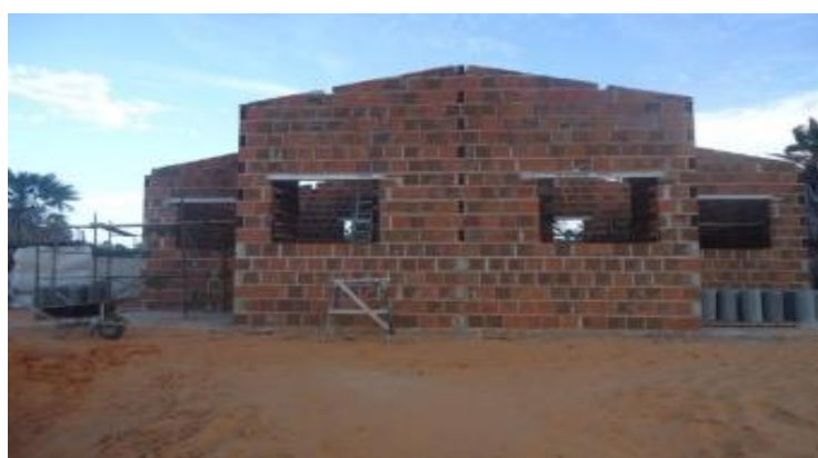
Figura 8 - Parede de uma construção com o eitão
