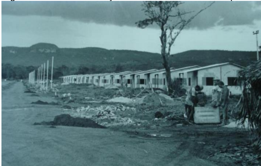
Figura 2. Palmas: construção das casas na Vila dos Deputados
