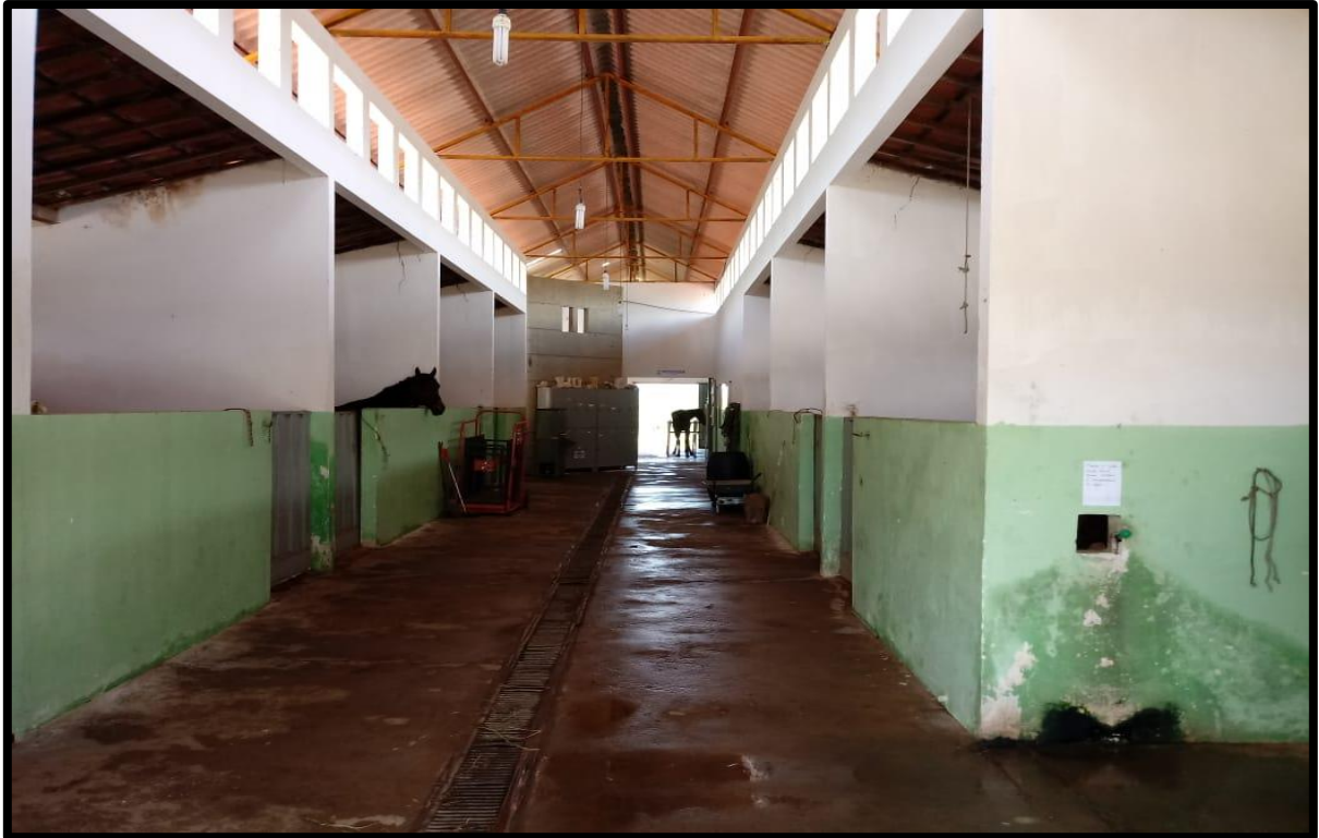
Figura 4: Baias para acomodação de equinos da Universidade Federal de Campina Grande (UFCG), Patos - PB.
