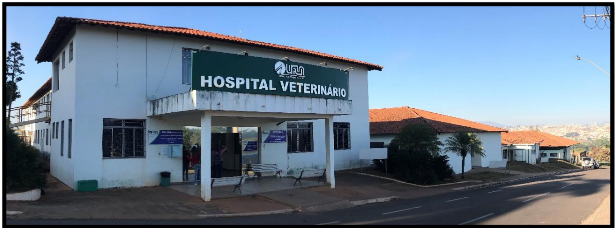
Figura 1 - Fachada do Hospital Veterinário Universitário – Universidade Federal de Lavras.
