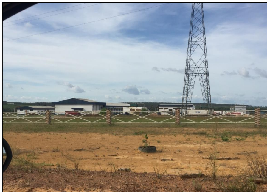
Figura 1- Vista frontal do Frigorífico Fortefrigo LTDA situado na cidade de Paragominas-PA
