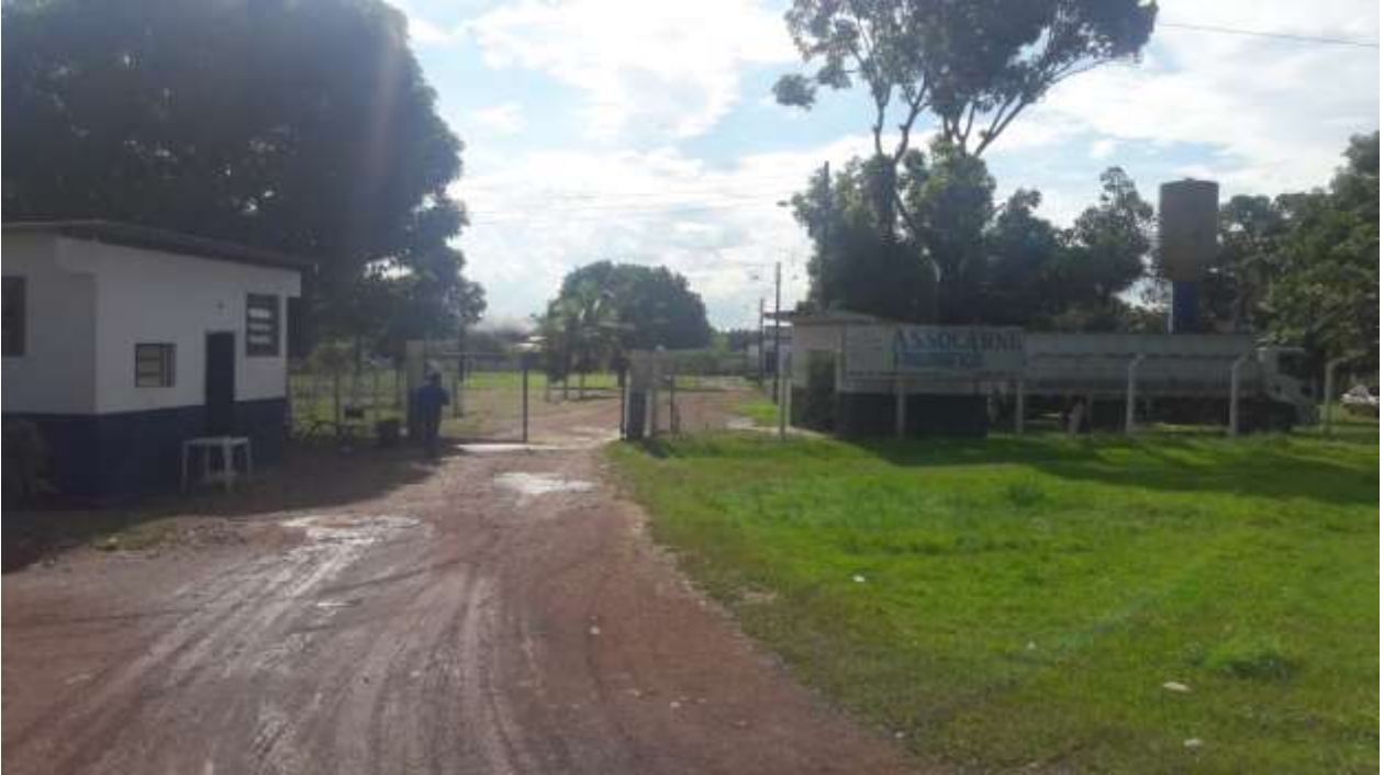
Figura 01 – Vista externa do Frigorífico – Associação do Comércio Estadual de Carnes Frescas e Derivados / ASSOCARNE – Matadouro-Frigorífico ASSOCARNE, 2017.
