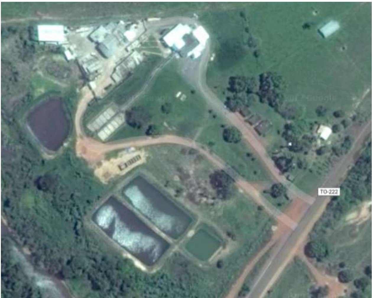
Figura 02 – Vista de satélite de toda a empresa ASSOCARNE. Fonte: Google Earth.
