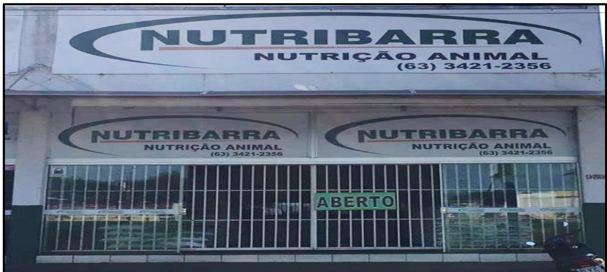
Figura 1: Vista frontal da empresa em Araguaína –TO.
