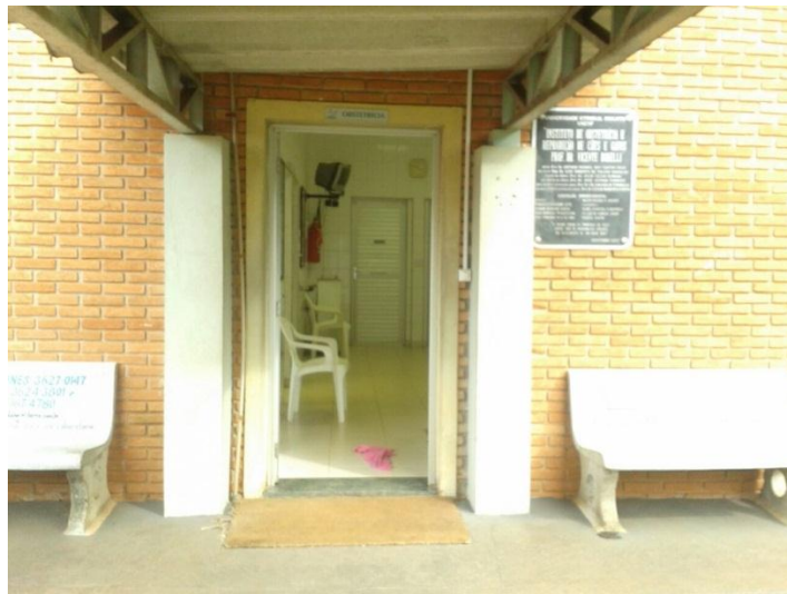
Figura 1: Vista externa do setor de Obstetrícia Veterinária do Hospital Veterinário “Governador Laudo Natel” da Faculdade de Ciências Agrárias e Veterinárias da Universidade Estadual Paulista (UNESP), Campus de Jaboticabal, São Paulo.
