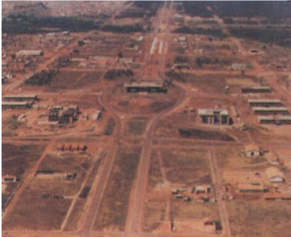
Figura 4: Foto aérea do início da construção de Palmas. Fonte: Fundação cultural de Palmas.
