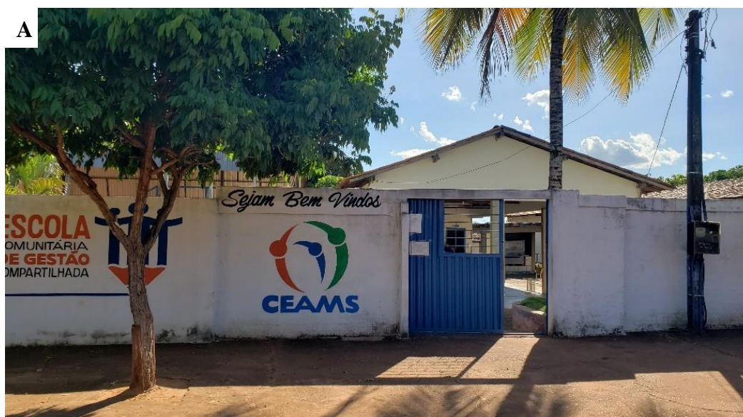
Figura 23: Frente, área externa da cantina, biblioteca e salas de aula
