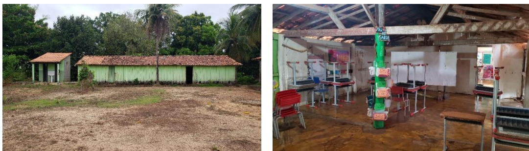
Figura 20: Fotos do segundo pavilhão e banheiro
