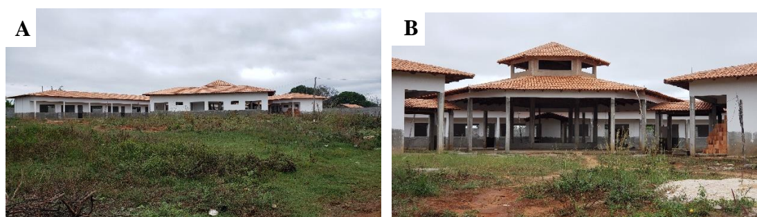
Figura 22: Construção da nova escola (padrão FNDE)
