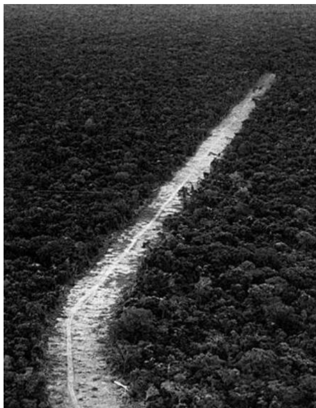
Figura 11: Início da construção da BR-230
