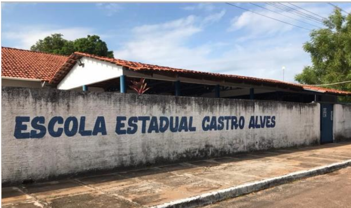
Figura 3 - Foto da fachada da entrada da Escola Castro Alves, em Santa Fé do Araguaia.
