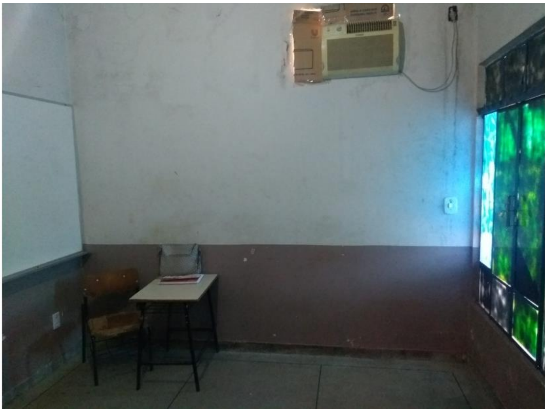
Figura 8 - Foto da sala de aula utilizada como 'seguro'
