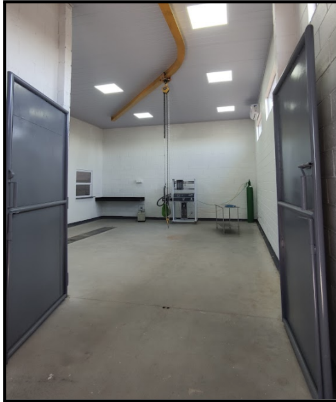
Figura 2. Entrada da sala de cirurgia. Foto tirada da sala de indução.
