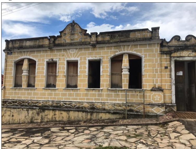
Fotografia 1- Fachada do Museu Histórico e Cultural de Arraias
