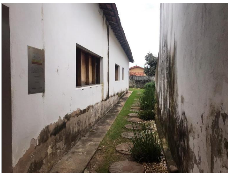
Fotografia 19 - Corredor externo do MHCA
