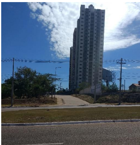
Figura 24 - Via criada para atender os edifícios residenciais, com acesso direto à Avenida JK. Foto: Bezerra, abr. 2017.
