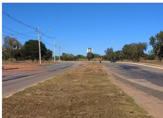
Figura 23 - Construção e duplicação de um trecho da avenida NS-7, que liga a avenida JK a área das ARSO's. Foto: Bezerra, abr. 2017.
